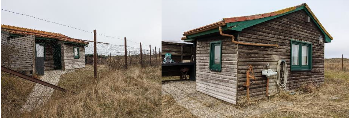
Abbildung 5: Ansicht der Hütte von Süden und Südosten
