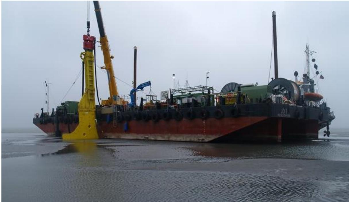
**Abbildung 8: Kabellegung im Wattenmeer mit Vibrationsschwert an Barge**
