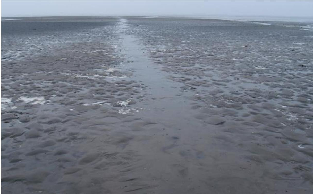
**Abbildung 9: Bereich des Verlegespalts wenige Stunden nach Einsatz des Vibrationschwerths (Bild 6)**
