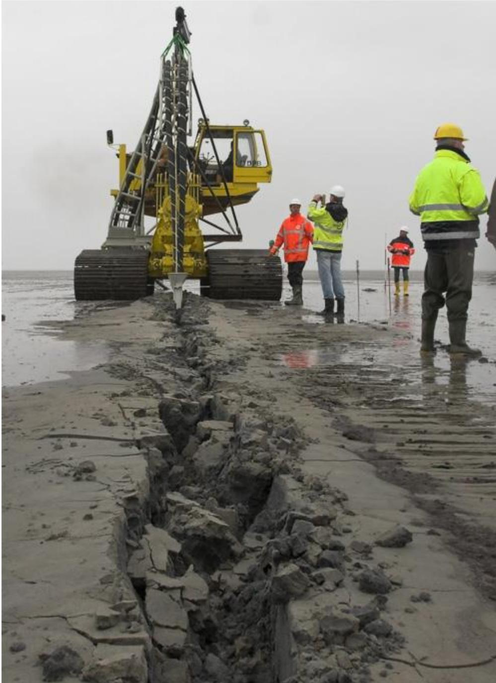
**Abbildung 5:** Kabellegung im Wattenmeer (Sandwatt) mit Vibrationskabelpflug
