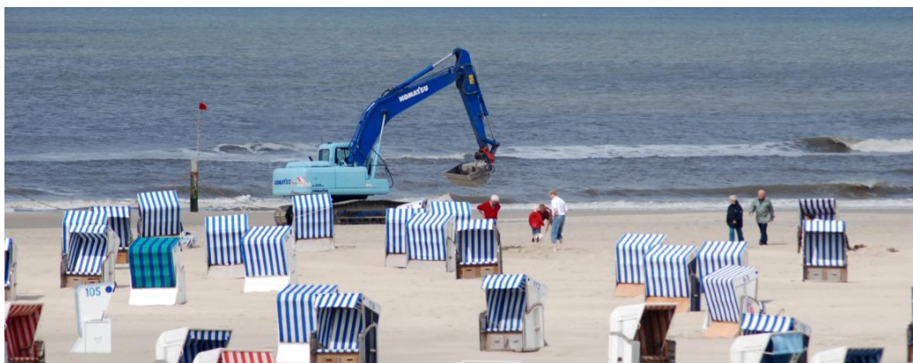
Abbildung 14: Baustellenverkehr am Badestrand bei Hochwasser
