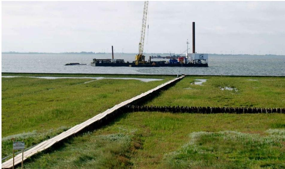
Abbildung 8: Beispielbild Zugangssteg aus Holz oberhalb einer Lahnung
