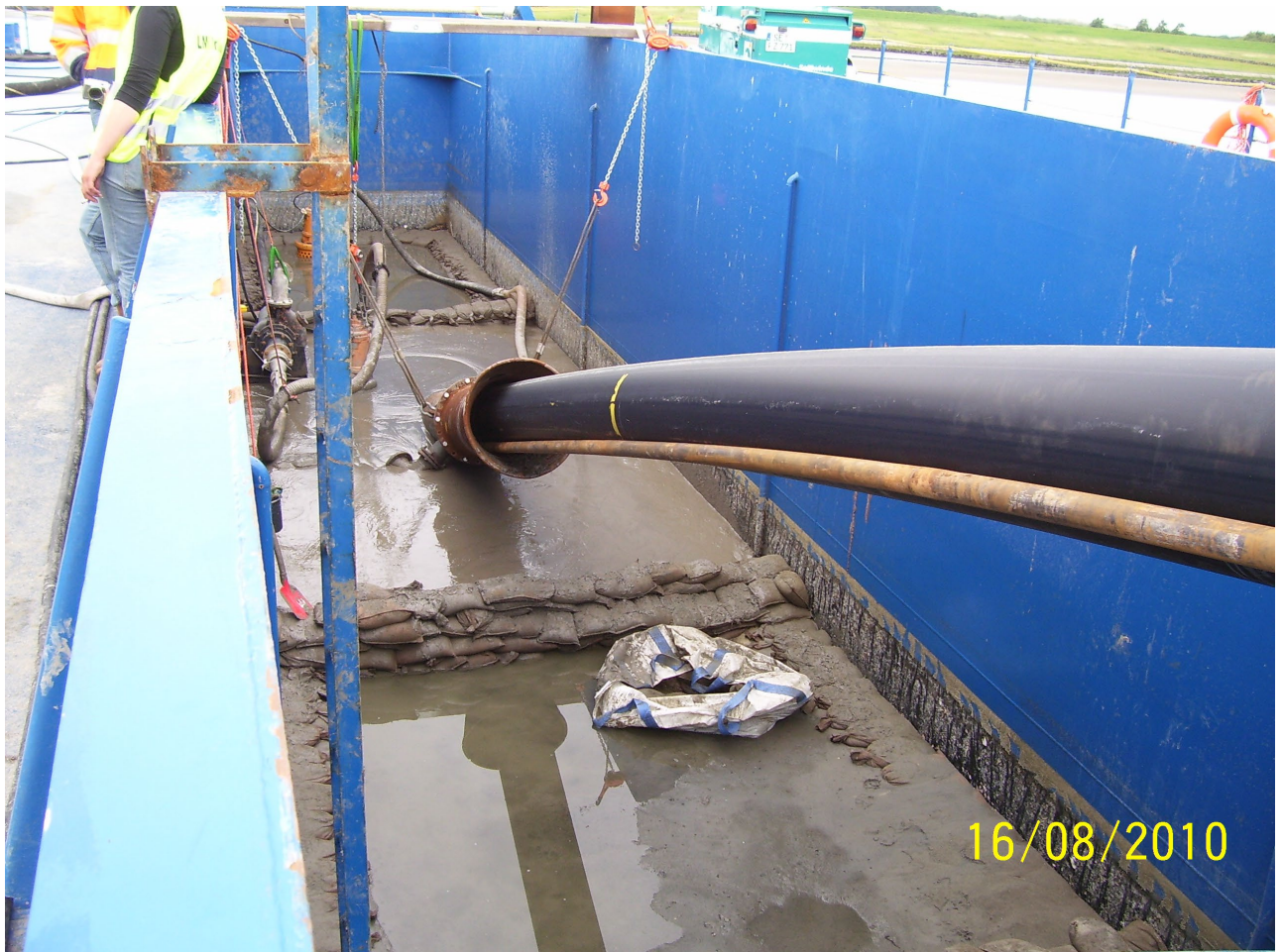
Abbildung 10: Beispiel (DolWin1) Einzug des Bohrgestänge mit dem Produktrohr (Pipe-Site)
