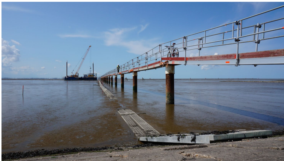
Abbildung 9: Beispielbild Zugangssteg Wattbereich (Gerüstbohlen auf Wattboden)
