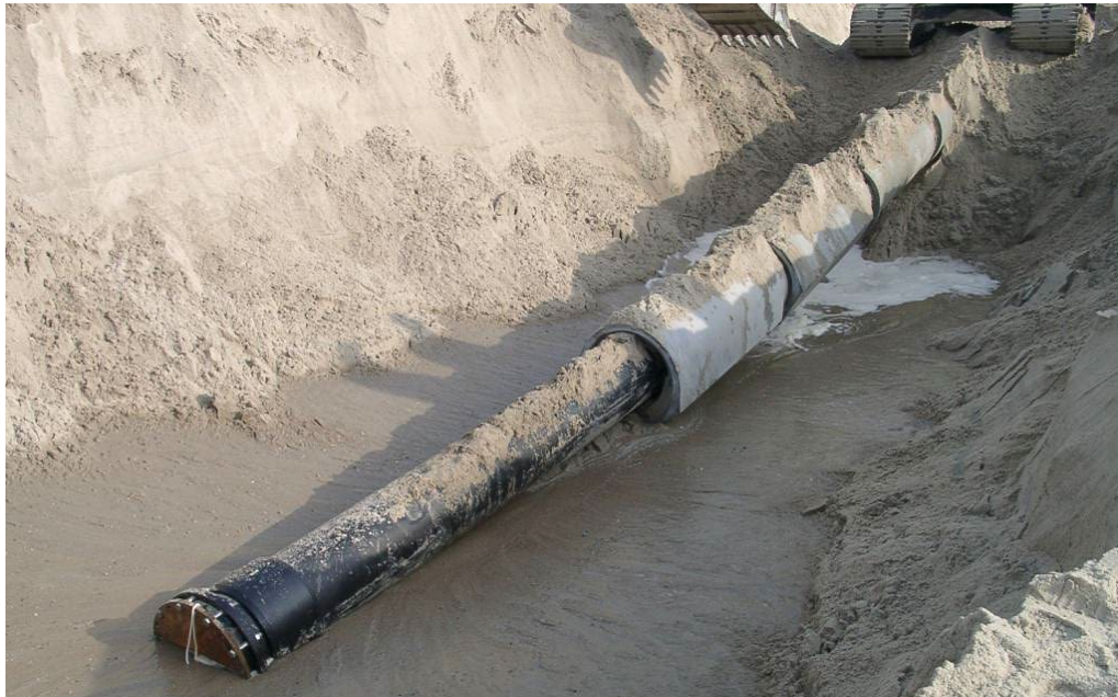
Abbildung 12: Mit äußerer Ballastierung versehenes Rohrende im Strandbereich (Beispielbild)
