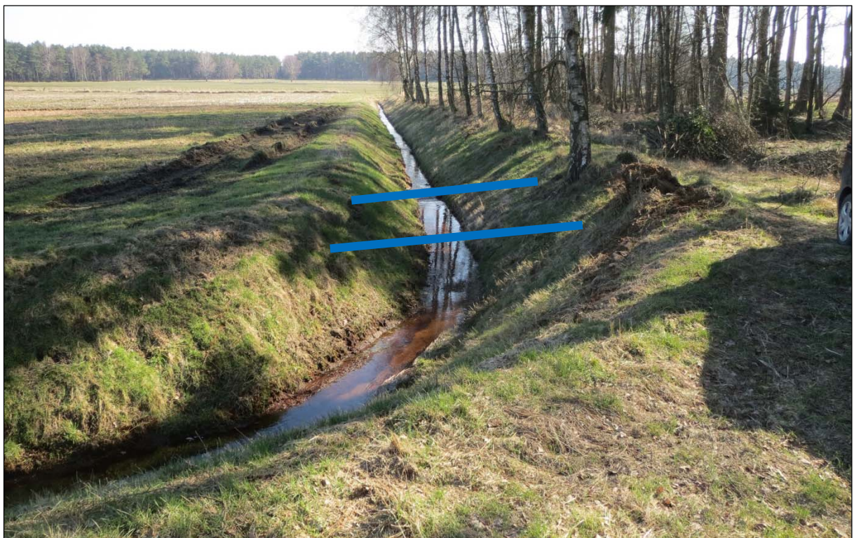
Abbildung 16: Teilbereich F-3, Ansicht des zu querenden Grabenabschnitts aus Richtung NNW
