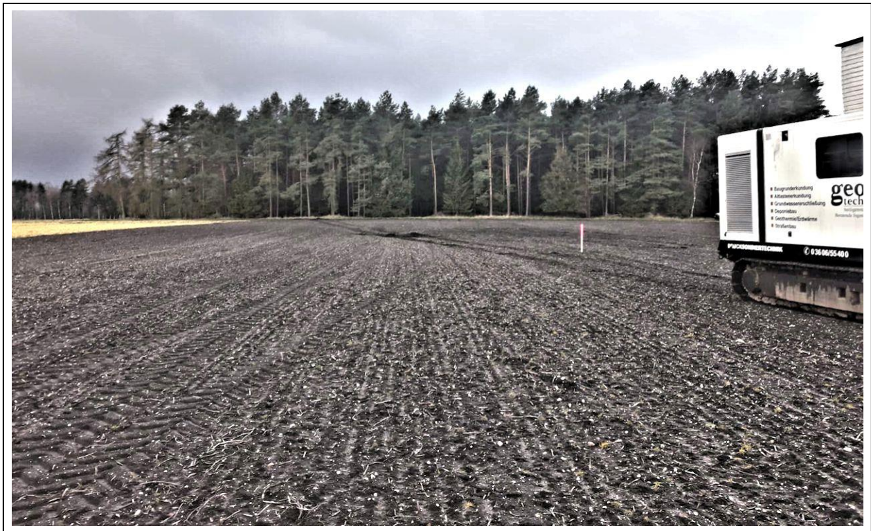
Bild 4.4: Blick in Richtung des geplanten Anlagenstandortes WEA 4
