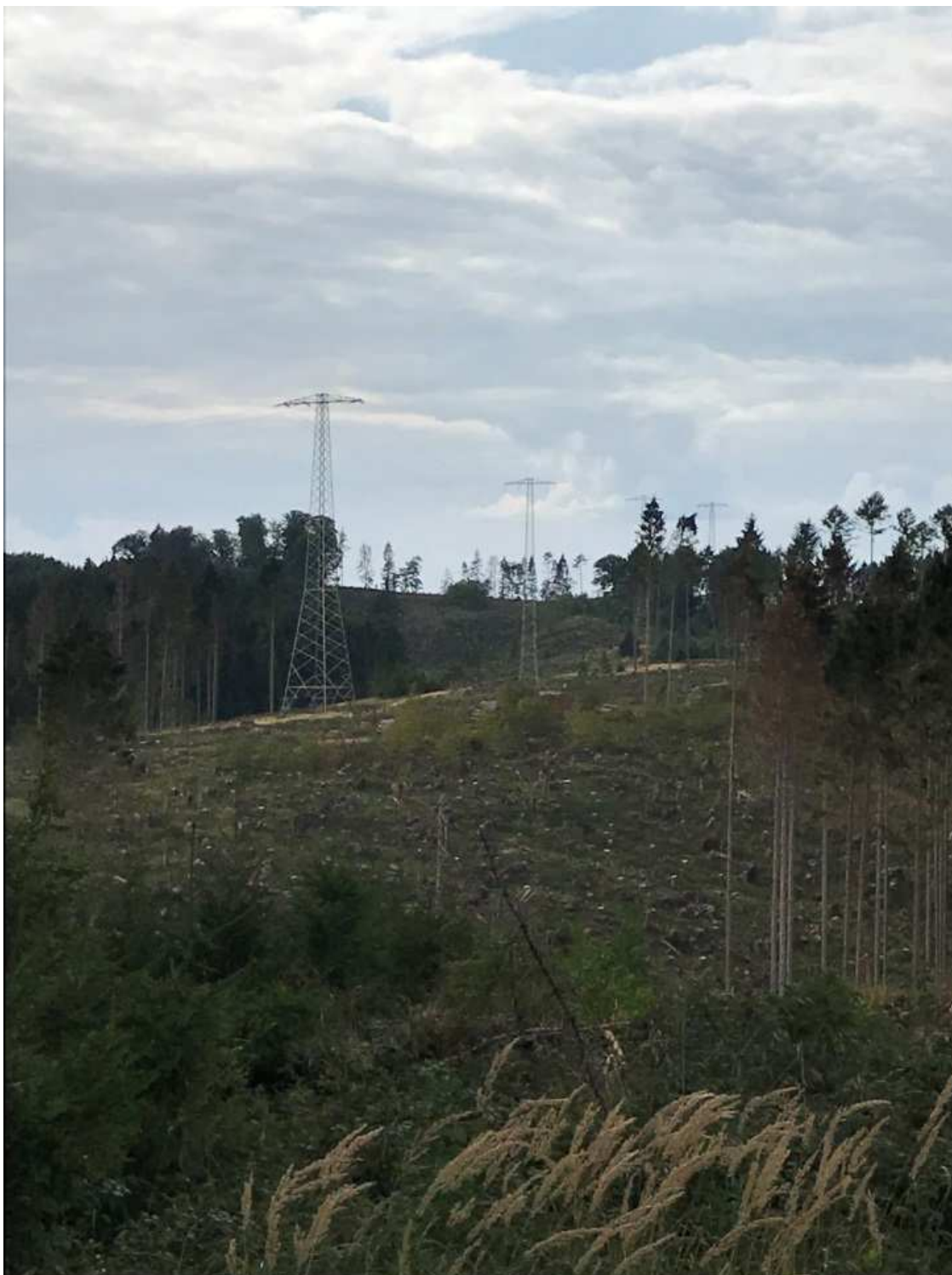
Abbildung 8: Örtliche Situation von Mast 81 bis Mast 84 Stand 07/2018 im Bereich Langenholtenser Wald
