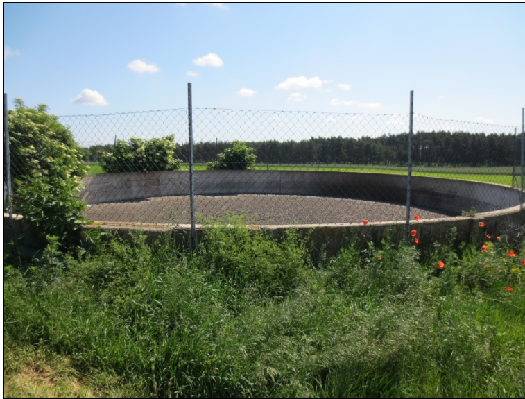
Abbildung 40: Speicherbecken auf Radenbecker Gemarkung
