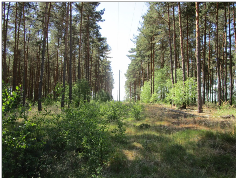
Abbildung 36: Trasse der 20kV-Freileitung
