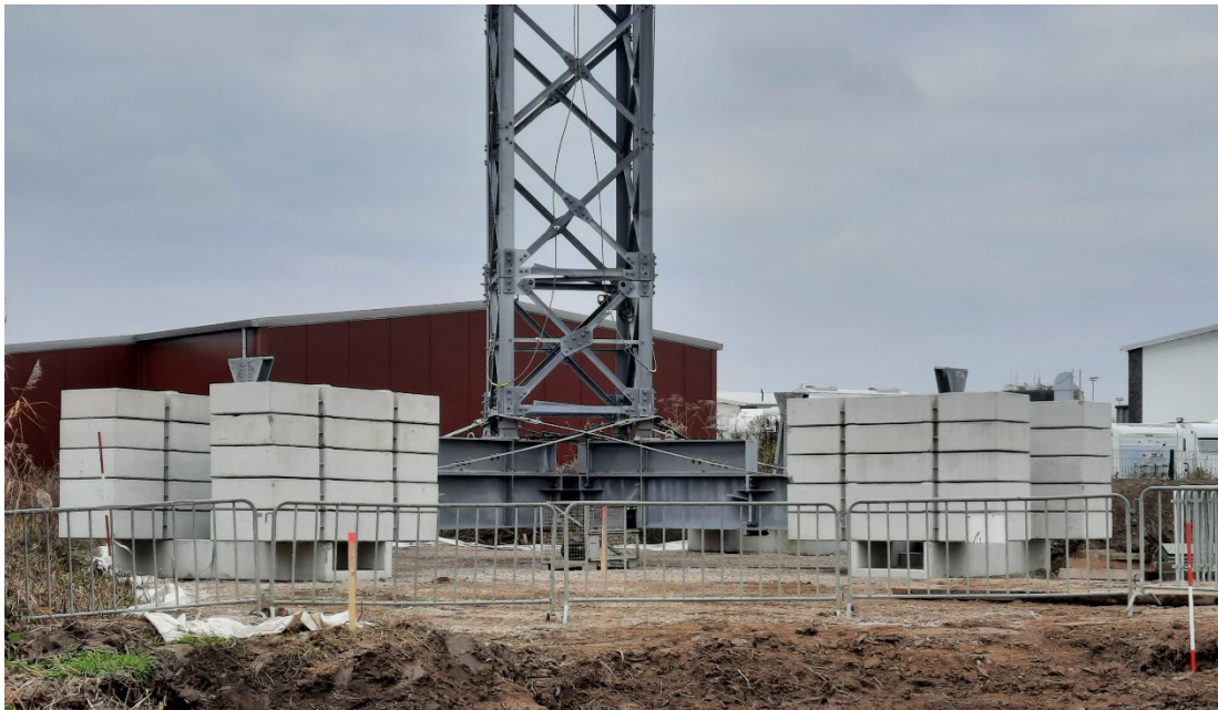
Abbildung 5: Fußkreuz eines CP-Masten mit Betonaufleger
