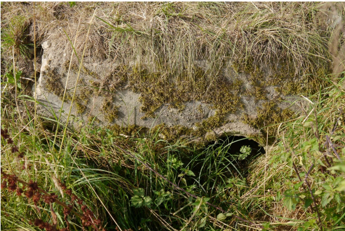
Foto 3: Durchlass (Rohr) nordwestlich WEA 3
