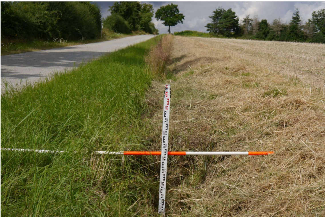
Foto 9: Seitengraben westlich Kranstellfläche WEA 6
