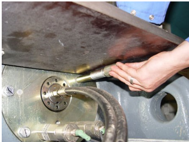
Abb. 17: Sichern der Rotorarretierung an der langsamen Welle – 3MW
