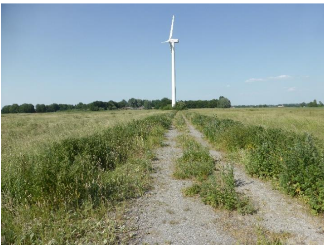
Abbildung 11: Zuwegung mit starkem Vegetationsaufwuchs Quelle: ARSU GmbH
