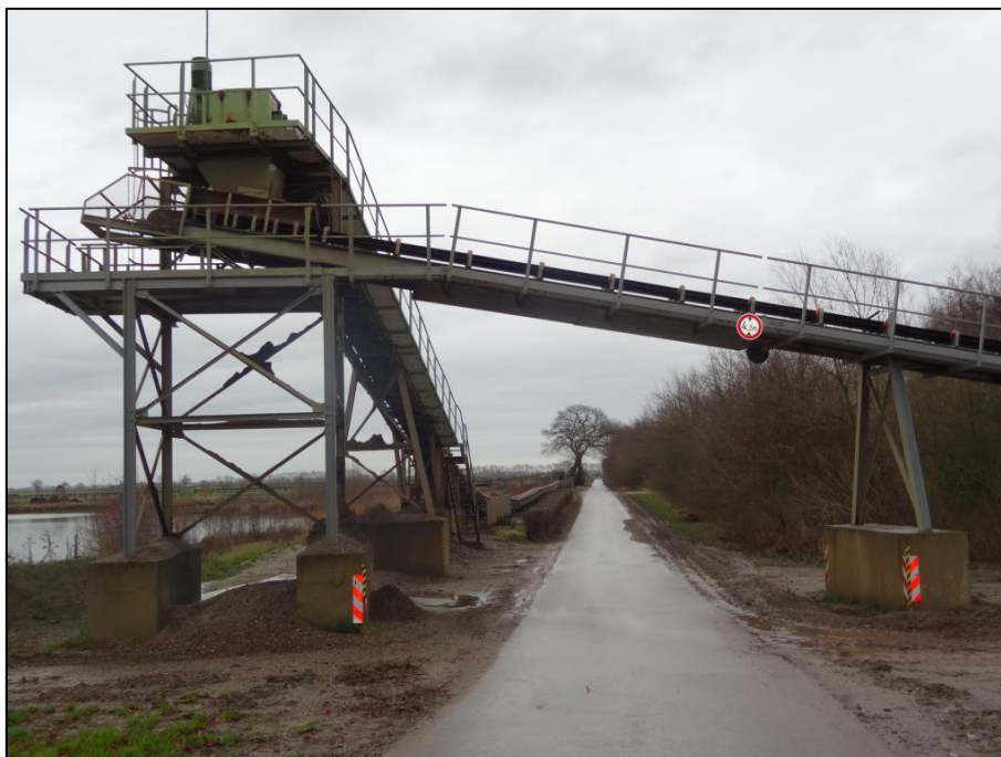
Abb. 7 Brücke der Bandstraße über einen Wirtschaftsweg im laufenden Abbaubereich
