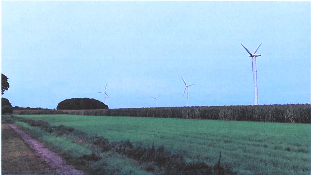
Abbildung 2: Blick auf die westliche Potenzialfläche mit den Bestands-WEA und Bullmersberg Foto: ARSU 19.01.2022
