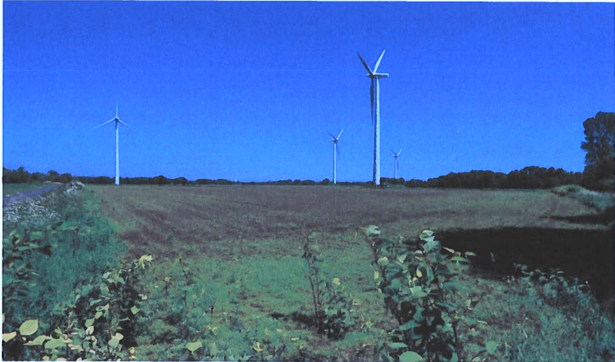
Abbildung 4: Blick auf die östliche Potenzialfläche mit Bestands-WEA Foto: ARSU 14.06.2021
