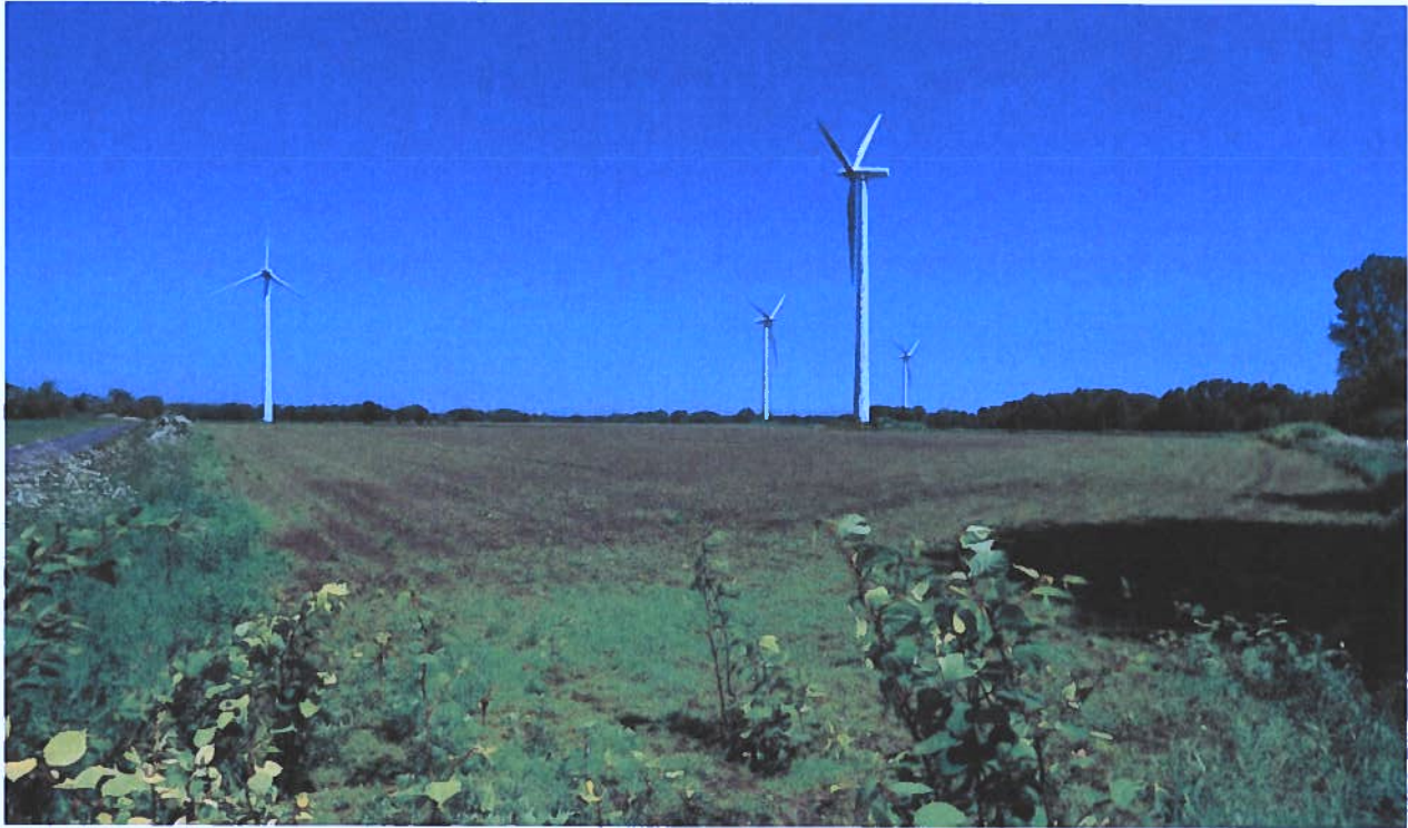
Abbildung 4: Blick auf die östliche Potenzialfläche mit den Bestands-WEA Foto: ARSU 14.06.2021
