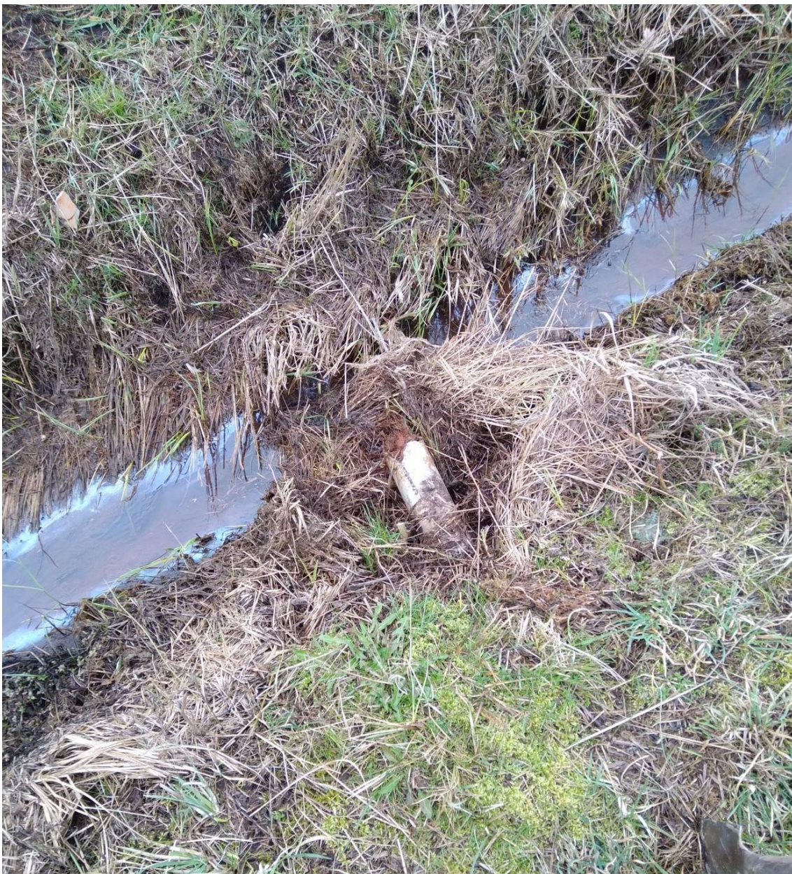
Foto 19: Kompensationsfläche A – Flurstück 68/7 – Drainageauslauf in nördlichen Graben (H&M 09.03.2023)
