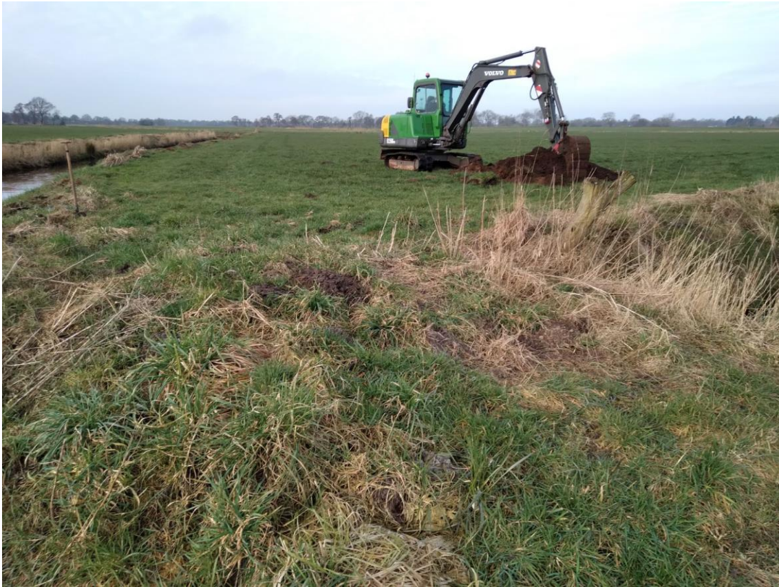
Foto 16: Kompensationsfläche A – Flurstück 67/5 – Baggerarbeiten östlichstes Drainagerohr (H&M 09.03.2023)
