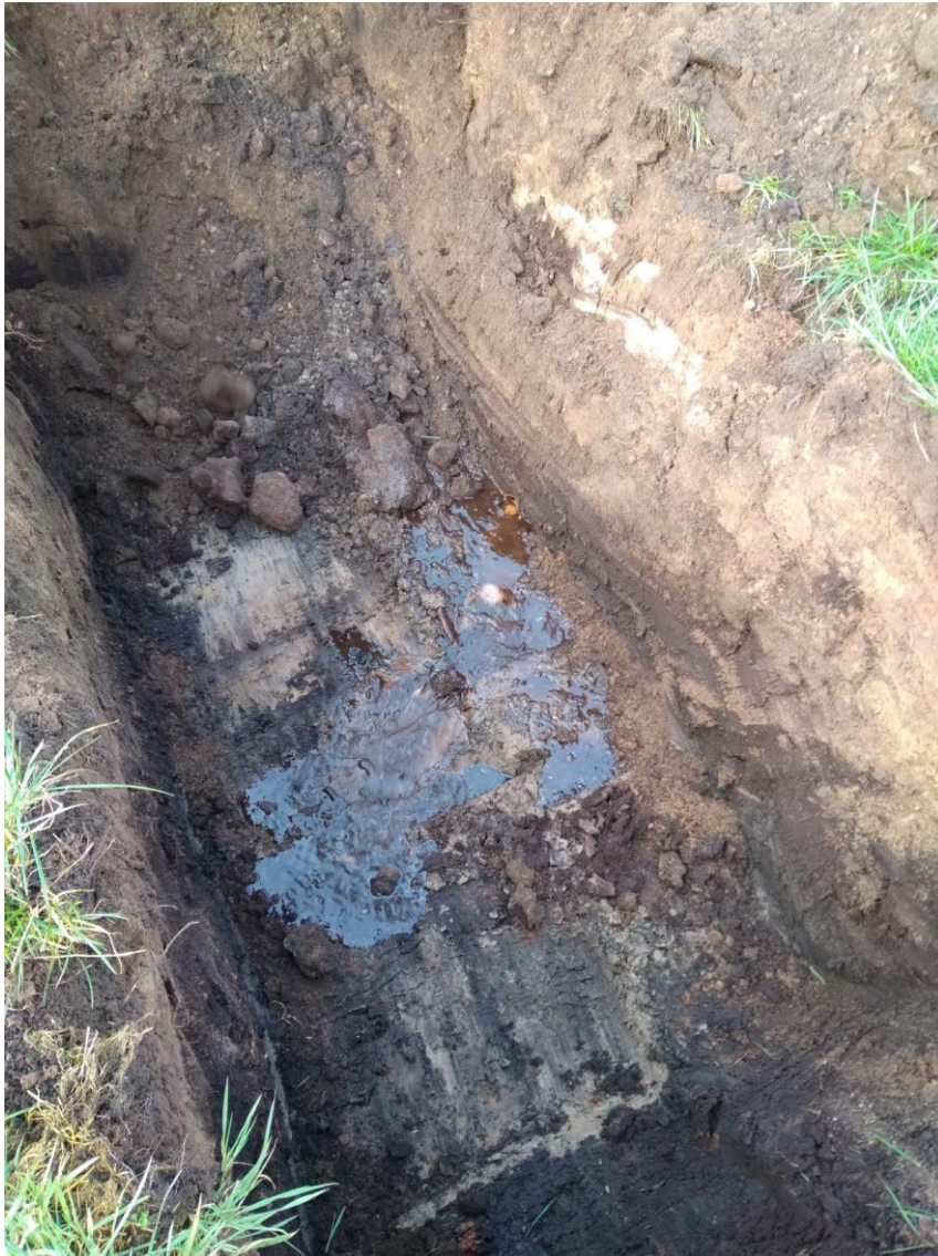
Foto 17: Kompensationsfläche A – Flurstück 67/5 – Baggerloch östlichstes Drainagerohr (H&M 09.03.2023)
