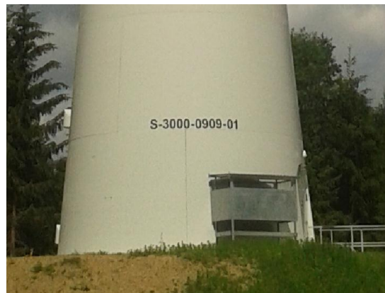
Abbildung 2: Beispielhafte WEA-NIS-Nummer an einer WEA.
