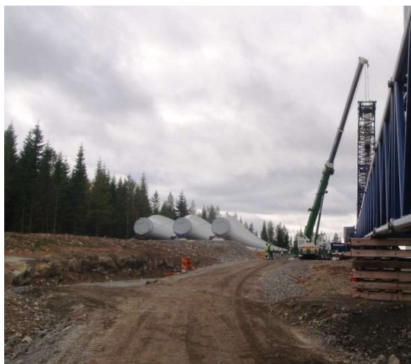
Abbildung 23: Beispiel für eine befestigte Fläche für den Hilfskran q2 in hügeligem Gelände. Die Gradient von q2 muss auf \leq 1,5\% nivelliert werden.
