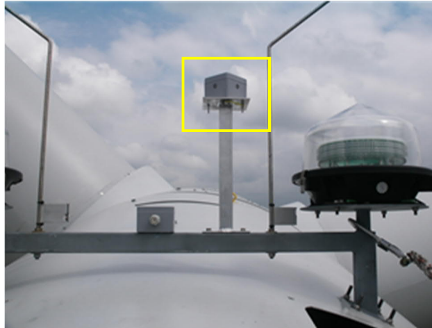
Abbildung 2: Oben auf der WEA-Gondel angebrachter Sensor (gelb hervorgehoben)
