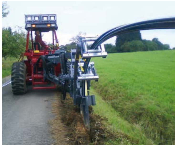
Abbildung 2: Beispiele Kabelverlegung in offener Bauweise (links) und mittels Kabelflug (rechts, Quelle: Frank Föckersperger GmbH)
