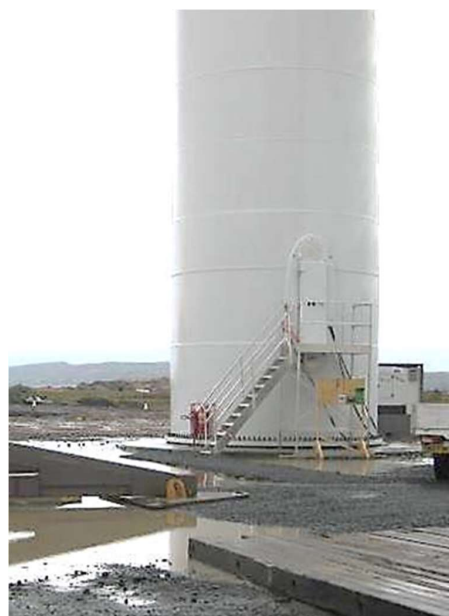
Abbildung 32 : Beispiel für eine nicht gut instandgehaltene Servicezufahrt zur WEA
