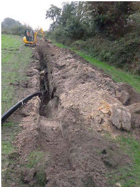
Abbildung 2: Beispiele Kabelverlegung in offener Bauweise (links) und mittels Kabelflug (rechts, Quelle: Frank Föckersperger GmbH)
