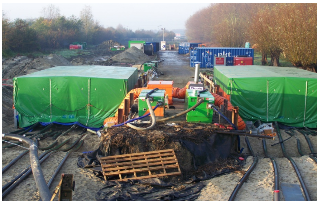
Abb. 3.4-5 Muffengrube mit Arbeitscontainer (Quelle: TenneT)
