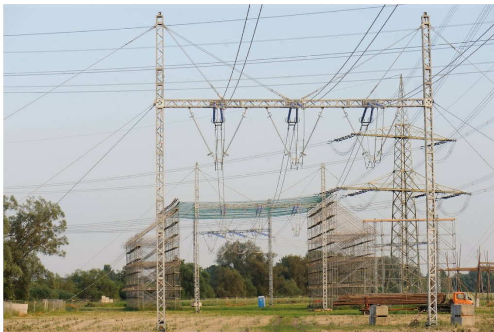
Abb. 3.3-4 380-kV Freileitungsprovisorium für ein System, mit errichtetem Schutzgerüst
