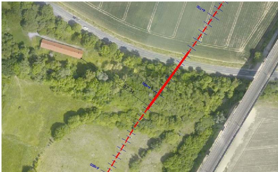
Abbildung 8: Annäherung der Kabeltrasse an ein Gebäude am östlichen Ortsrand der Gemeinde Olenhusen
