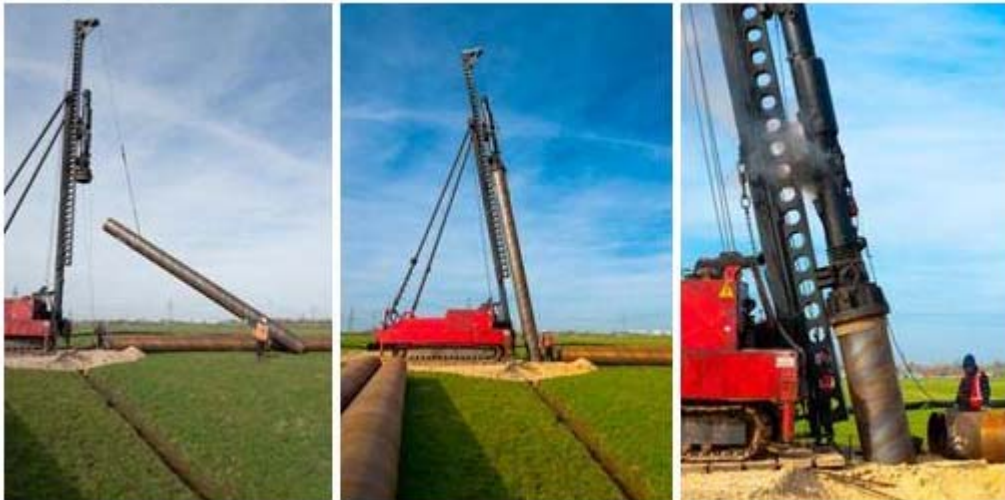
Abbildung 16: Pfahlgründung (Quelle: TenneT TSO GmbH)
