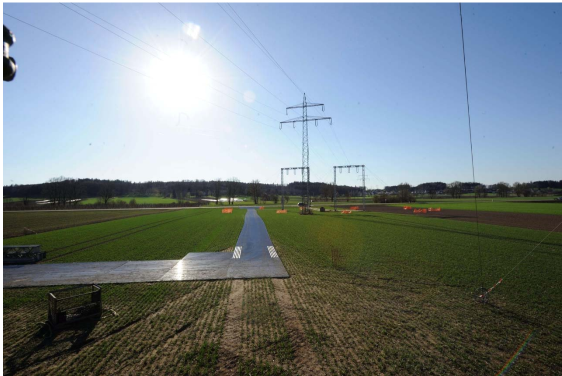
Abbildung 7: Provisorische Zuwegung als Plattenzufahrt bei einer Freileitungsbaustelle
