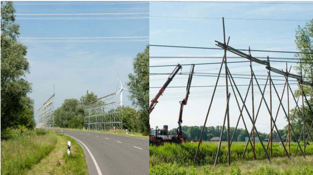
Abbildung 20: Beispiele für Schutzgerüste aus Stahl bzw. Holz
