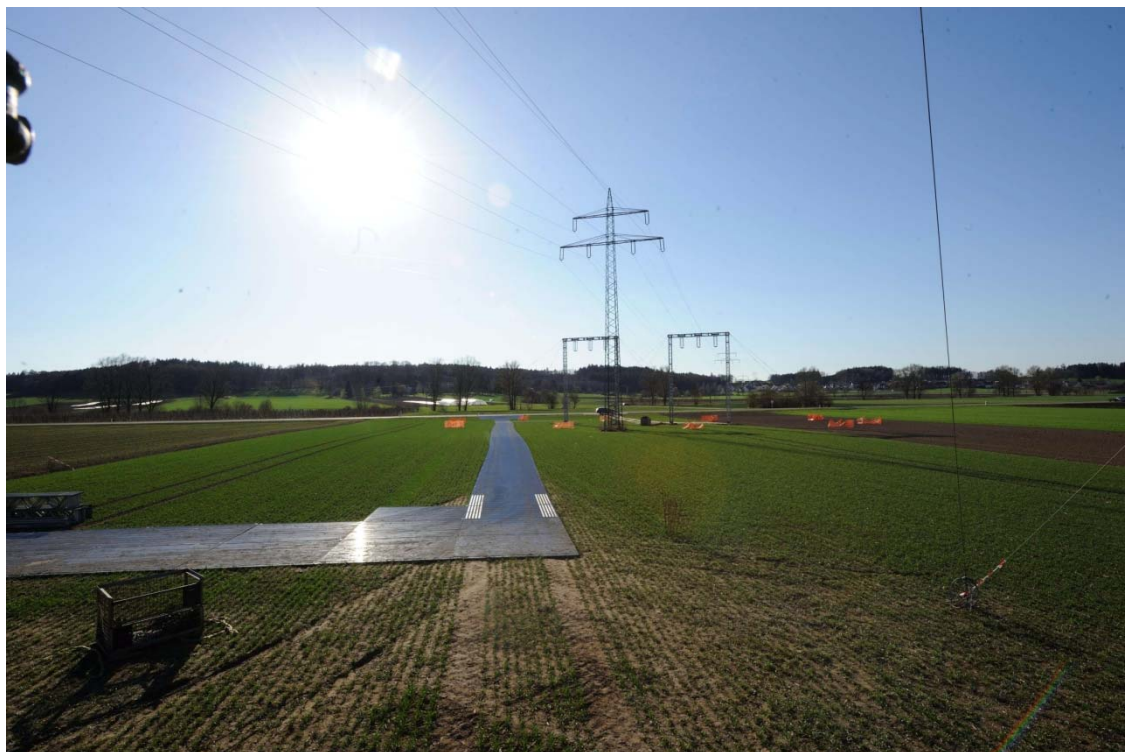
Abbildung 15: Provisorische Zuwegung als Plattenzufahrt bei einer Freileitungsbaustelle
