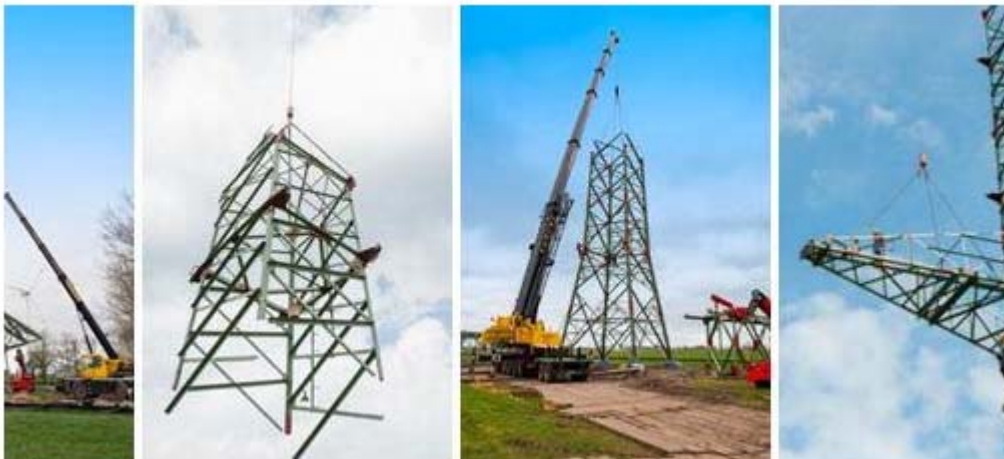
Abbildung 17: Stocken eines Freileitungsmastes (Quelle: TenneT TSO GmbH)
