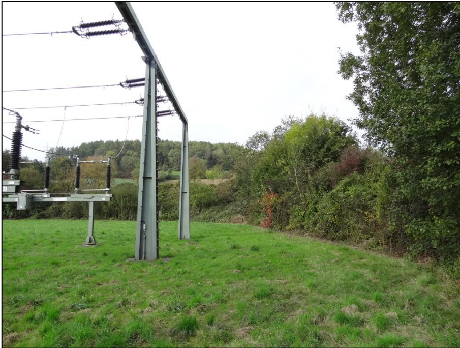
Abb. 7 Gehölzriegel an der West- und Nordgrenze (Foto 6 in Anlage 1)
