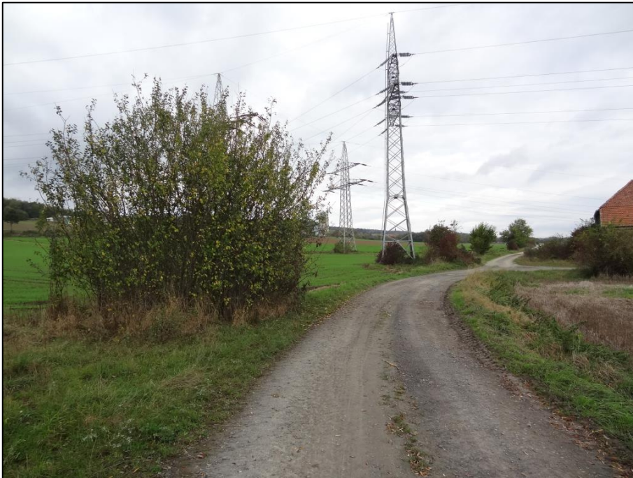
Abb. 11 Einzelgehölz und Feldscheune am Nordrand der Erweiterung (Foto 10 in Anlage 1)
