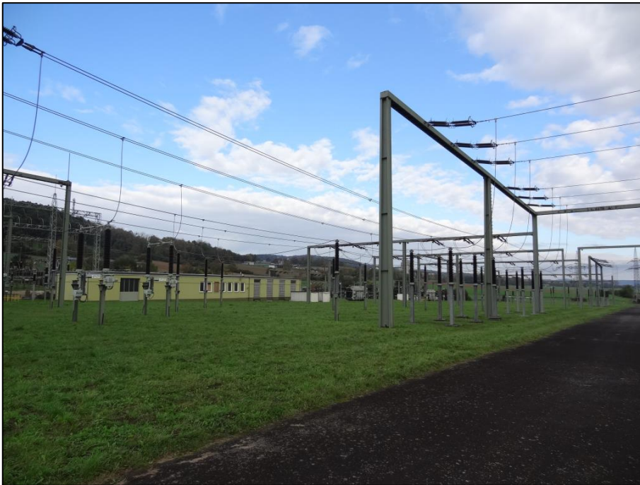
Abb. 2 Betriebsgebäude am Hauptweg (Abriss geplant) (Foto 1 in Anlage 1)
