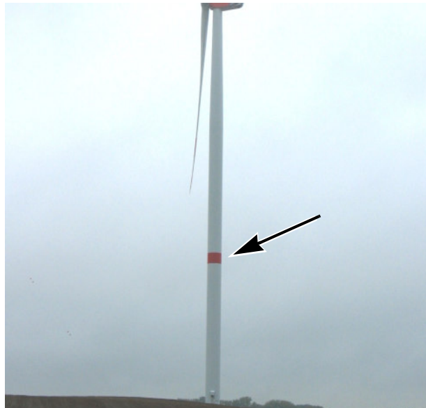
Abb. 4 Roter Farbring an Anlage mit Gesamthöhe >150 m
