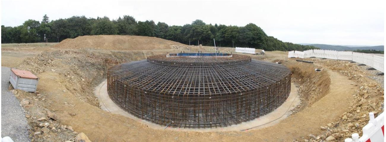
Abb. 2: Beispiel für den Bau des Flachfundaments einer Windenergieanlage, Quelle: BGU
