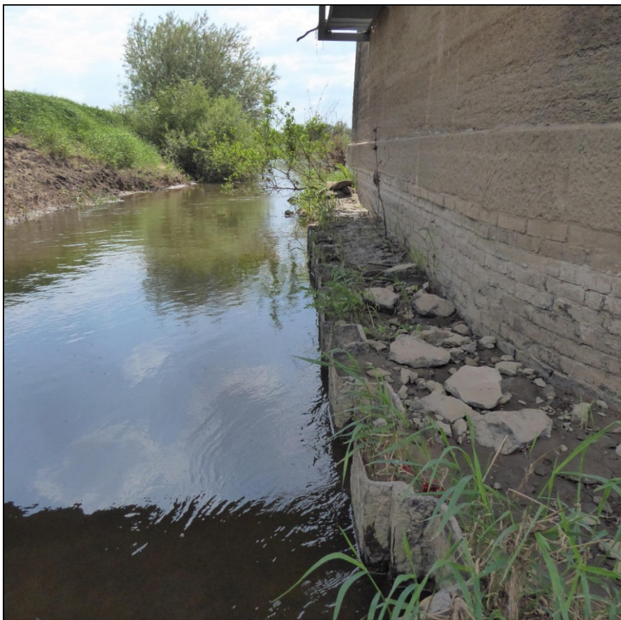
Abb. A1-9: Aller, Probestelle 3, Brückenpfeiler, Uferseite, 15.5.2018.
