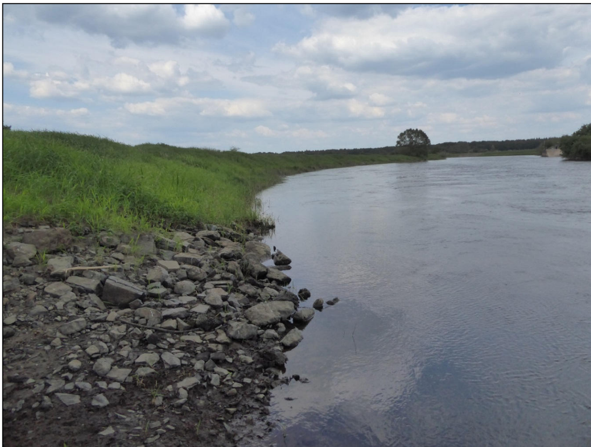
Abb. A1-12: Aller, Probestelle 4, linkes Ufer, flussabwärts, 15.5.2018.
