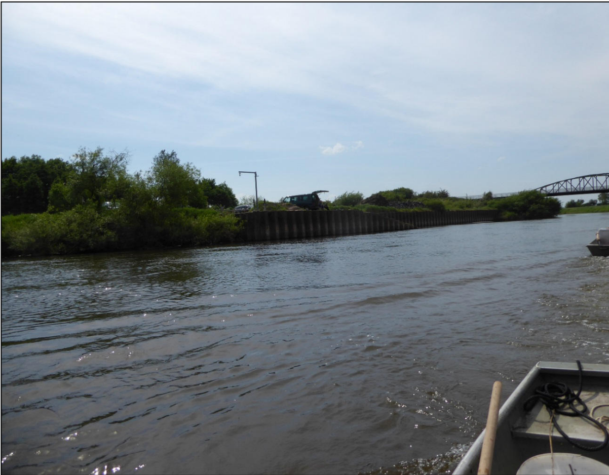
Abb. A1-8: Aller, Probestelle 2, 100 m unterhalb der Brücke, rechtes Ufer, 15.5.2018.
