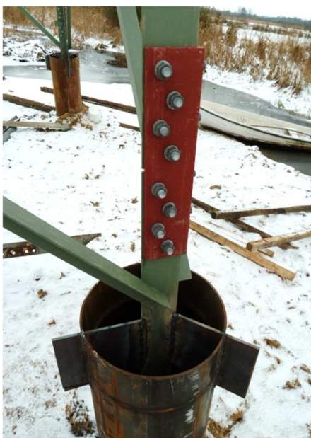
Abbildung 10: Schemazeichnung und Beispielfoto eines Rammpfahlfundamentes
