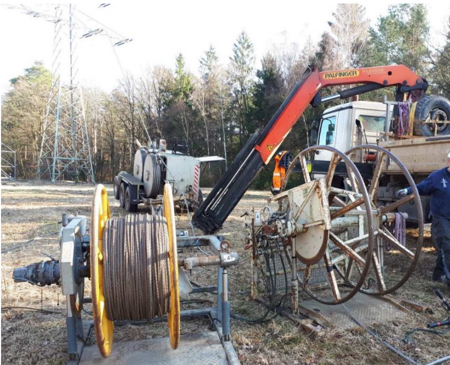
Abbildung 12: Beispiel für ein Seilzugverfahren (vorne: Seiltrommel, hinten: Seilzugmaschine)
