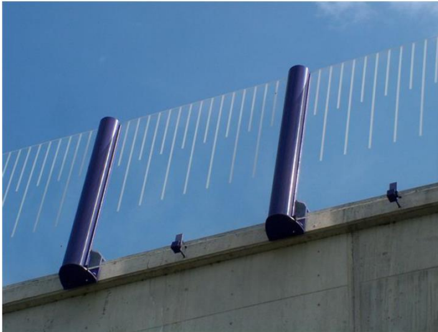
Abbildung 11: Transparente Lärmschutzwand mit vertikalen Markierungen als Überflughilfe für Vögel (aus: TROCMÉ 2006)
