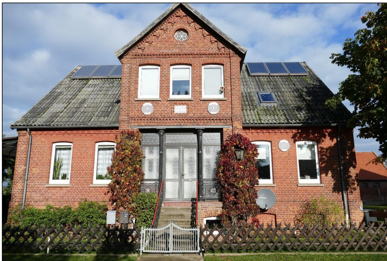
Abbildung 4: BP 1 ‚Zur Mühle 1‘ (Südfassade) – Blickrichtung Nord [Quelle: Ramboll Deutschland GmbH, Standortbegehung vom 22.10.2019]
