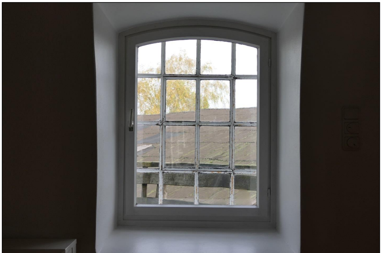
Abbildung 14: BP 2 ‚Zur Mühle 4‘ – Blick aus dem NNO Fenster des Wohnzimmers (Richtung WEA 01) [Quelle: Ramboll Deutschland GmbH, Standortbegehung vom 22.10.2019]
