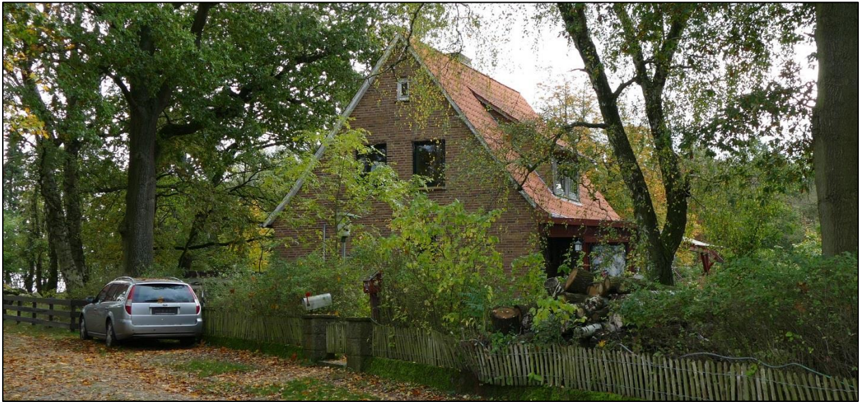
Abbildung 16: BP 3 ‚Zur Mühle 2‘ (Nord- und Westfassade), Wohnhaus mit Wintergarten – Blickrichtung Südost [Quelle: Ramboll Deutschland GmbH, Standortbegehung vom 22.10.2019]
