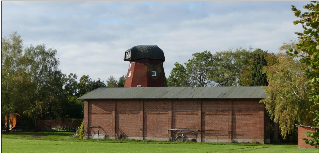
Abbildung 10: BP 02 ‚Zur Mühle 4‘ (Ostfassade, Nebengebäude in Richtung der geplanten WEA – Blickrichtung West [Quelle: Ramboll Deutschland GmbH, Standortbegehung vom 22.10.2019]
