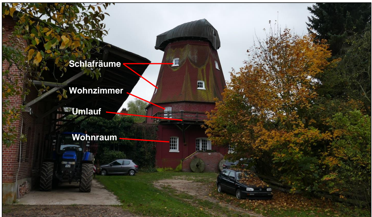
Abbildung 9: BP 2 ‚Zur Mühle 4‘ (Nordfassade) – Blickrichtung Süd [Quelle: Ramboll Deutschland GmbH, Standortbegehung vom 22.10.2019]
