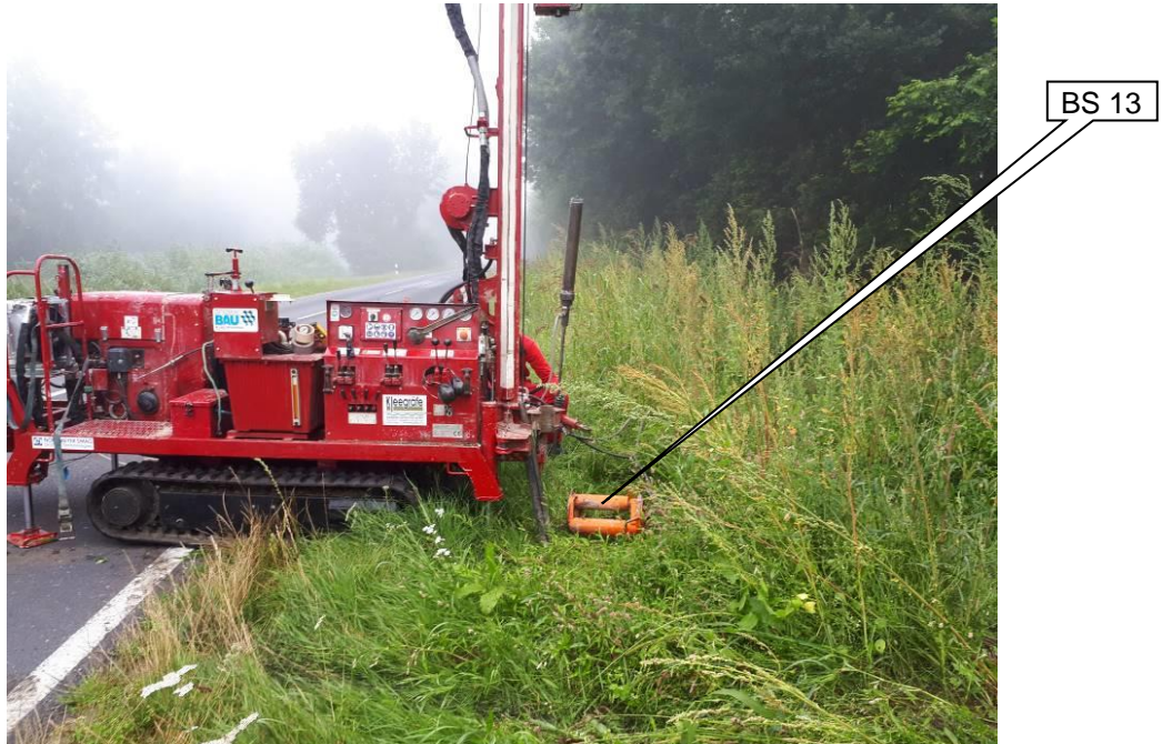
Foto 23: Bereich der Bohrung BS 13 (Markierung), Blickrichtung ~ W
