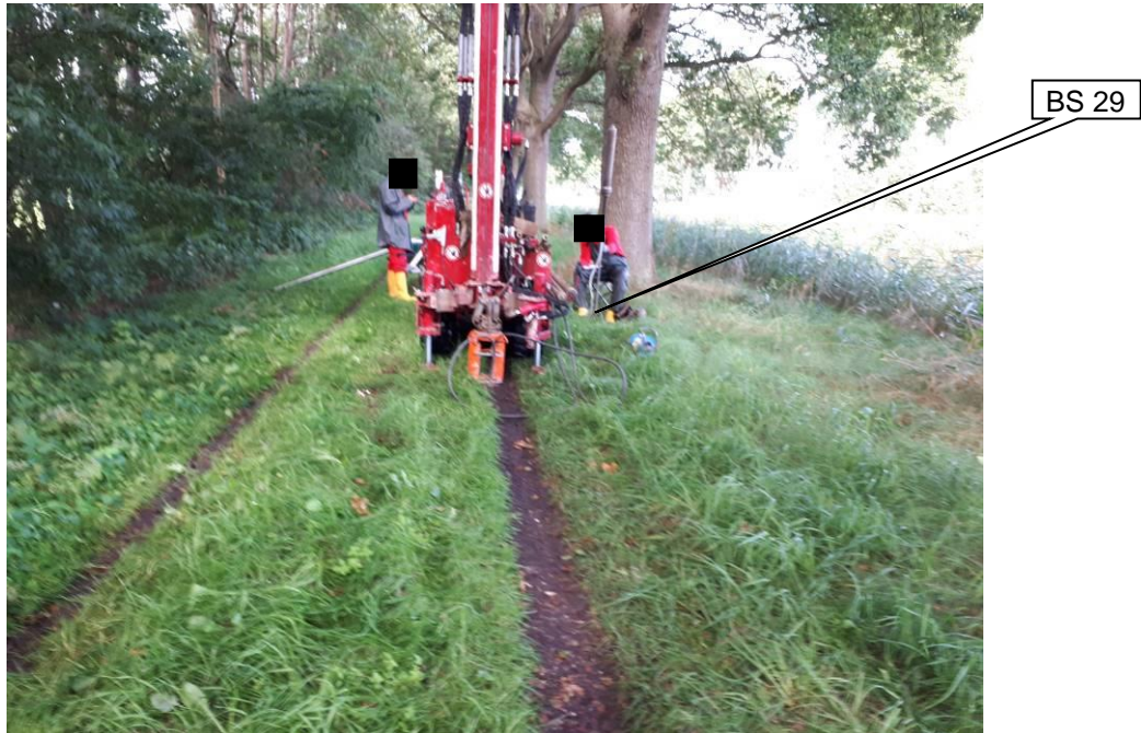
Foto 45: Bereich der Bohrung BS 29 (Markierung), Blickrichtung ~ W
