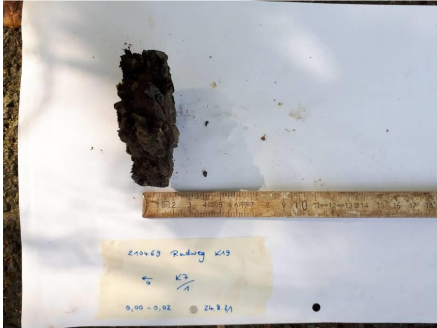
Foto 11: Detailfoto Kern K7/1 (0,00-0,02 m) der Kernbohrung K 7
