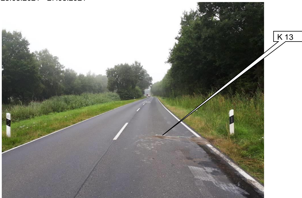
Foto 24: Bereich der Kernbohrung K 13 (Markierung), Blickrichtung ~ O
