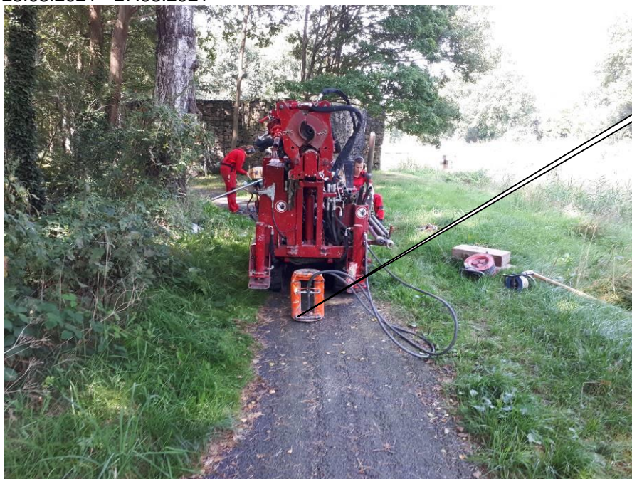
Foto 14: Bereich der Bohrung BS 8 (Markierung), Blickrichtung ~ W
