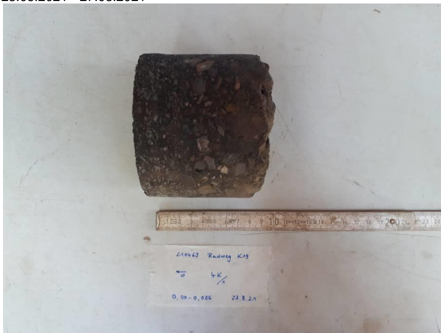
Foto 4: Detailfoto Kern K3/1 (0,00-0,085 m) der Kernbohrung K 3
