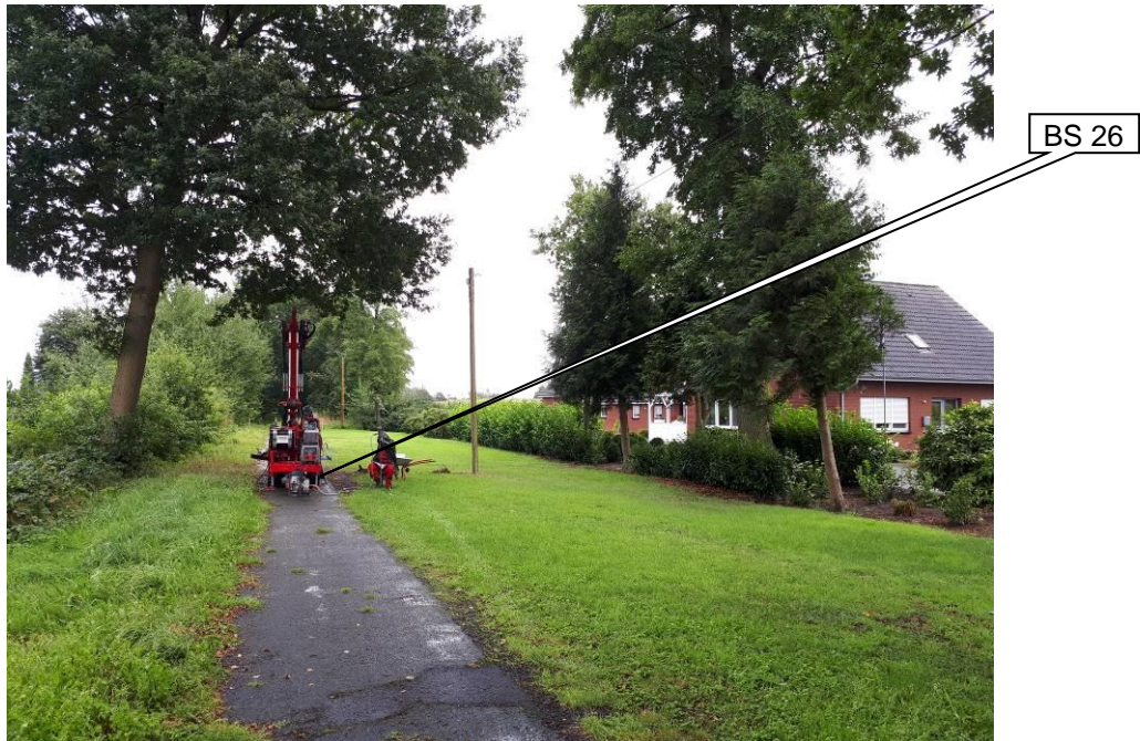
Foto 42: Bereich der Bohrung BS 26 (Markierung), Blickrichtung ~ W
