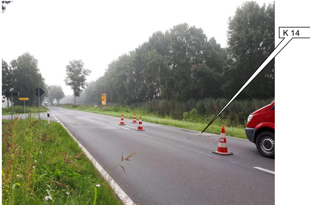
Foto 27: Bereich der Kernbohrung K 14 (Markierung), Blickrichtung ~ O
