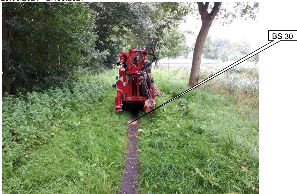
Foto 46: Bereich der Bohrung BS 30 (Markierung), Blickrichtung ~ W
