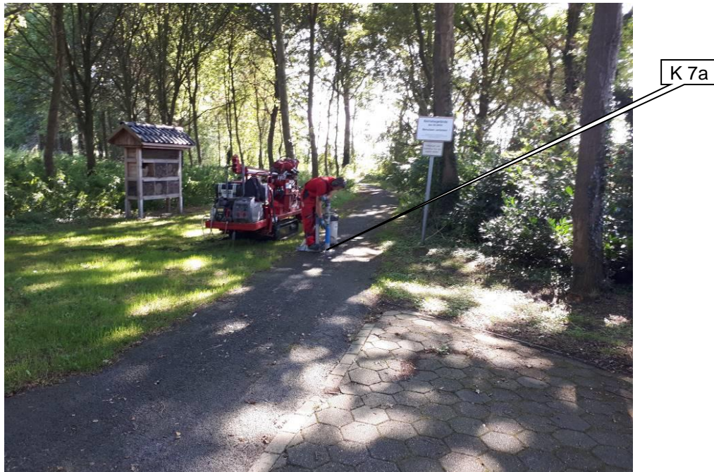
Foto 12: Bereich der Kernbohrung K 7a (Markierung), Blickrichtung ~ O
