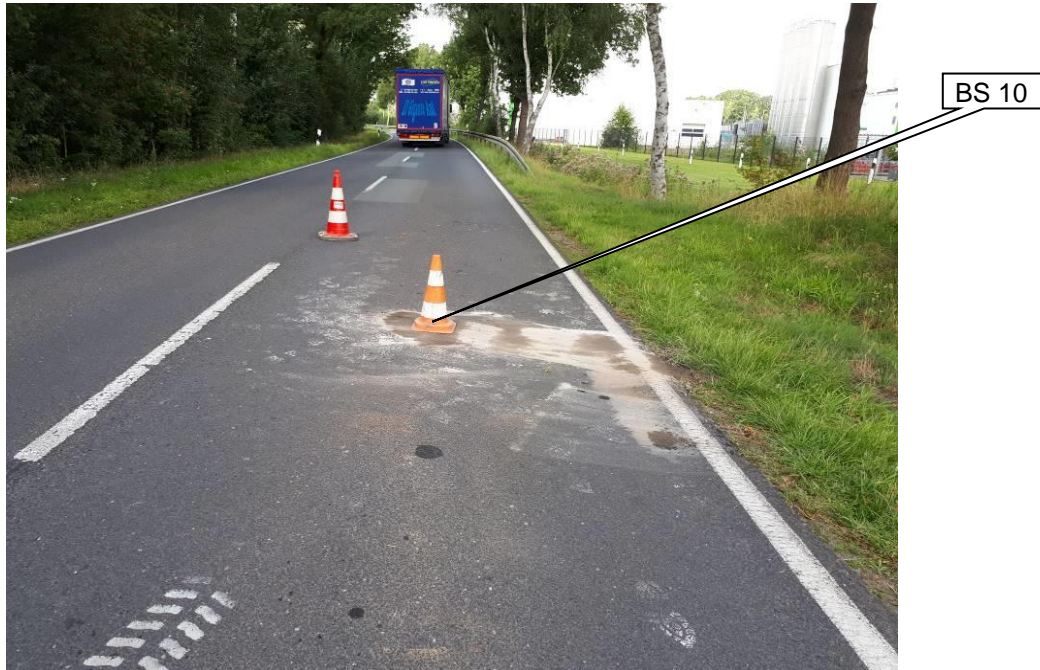
Foto 17: Bereich der Bohrung BS 10 (Markierung), Blickrichtung ~ W
