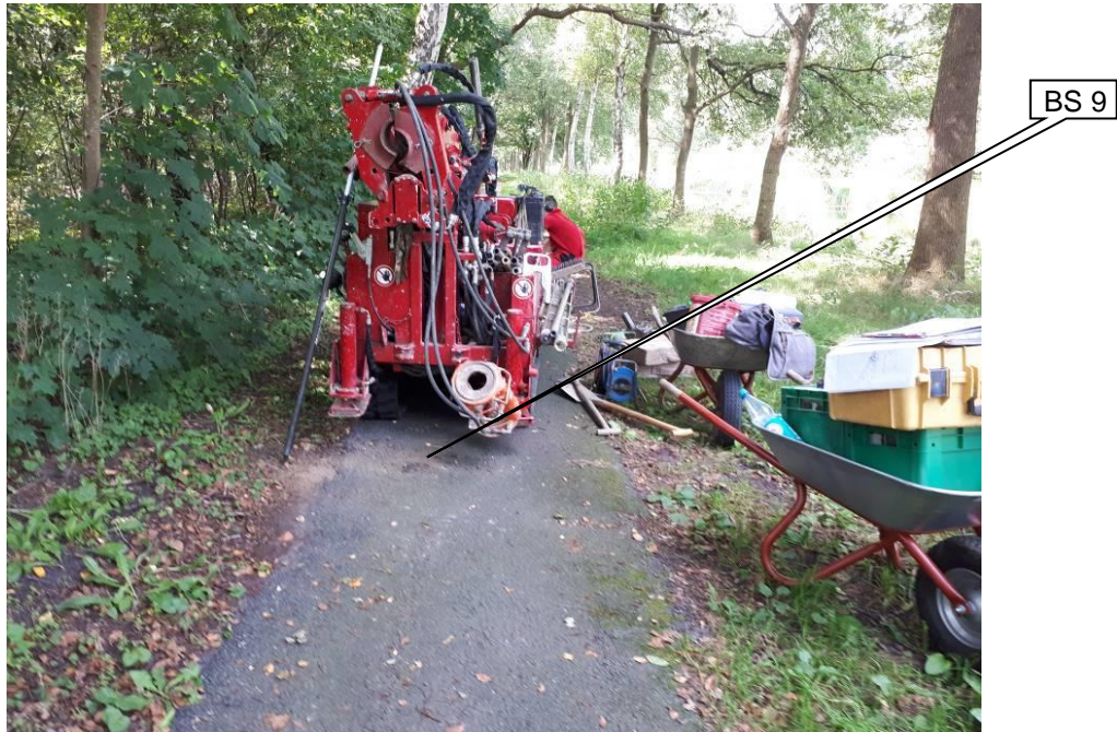
Foto 15: Bereich der Bohrung BS 9 (Markierung), Blickrichtung ~ W
