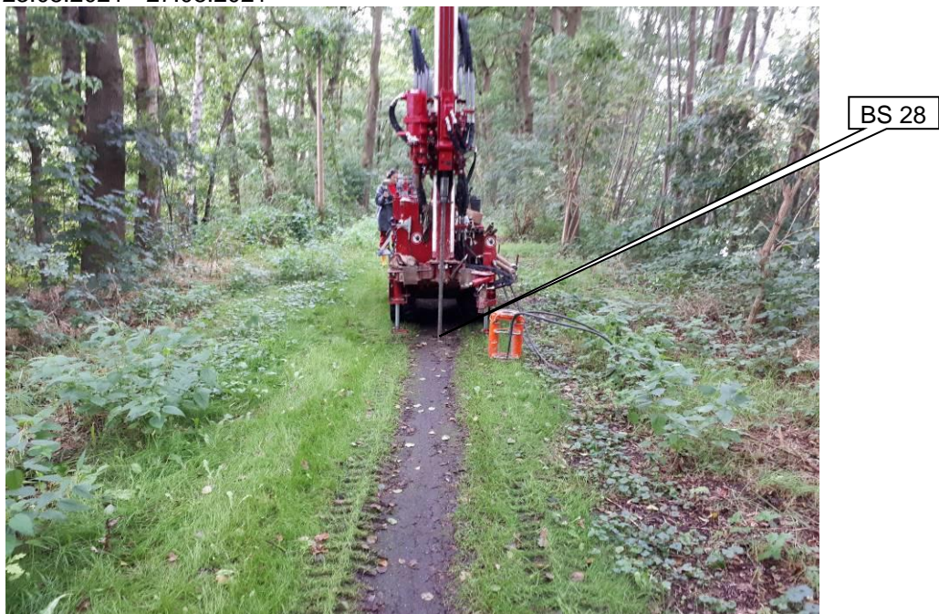
Foto 44: Bereich der Bohrung BS 28 (Markierung), Blickrichtung ~ W
