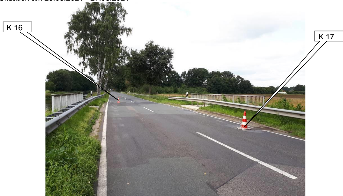
Foto 30: Bereich der Kernbohrungen K 16 und K 17 (Markierungen), Blickrichtung ~ W
