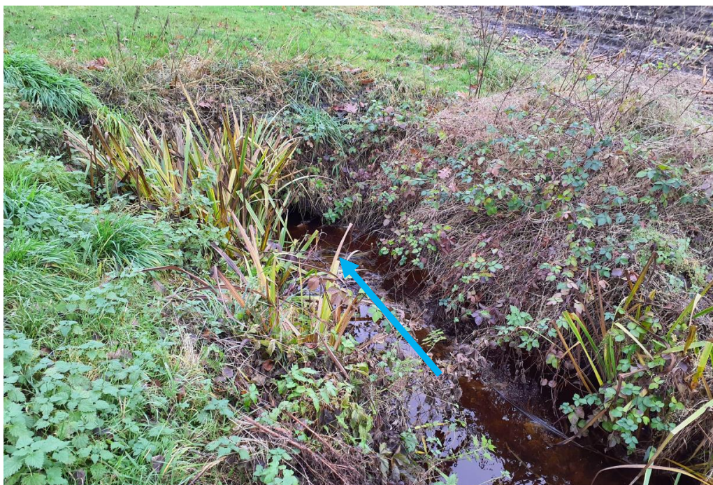
Abbildung 40: Graben südöstlich der Hinrich-Wilhelm-Kopf-Straße mit Einlauf Rohrleitung DN600
