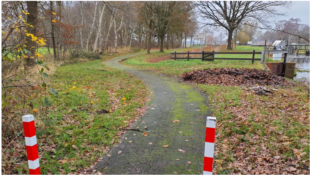
Abbildung 13: Verschwenken des Unterhaltungsweges an ehemaliger Schleuse bei 43+700
