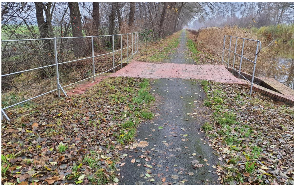
Abbildung 16: gemauertes Querungsbauwerk bei 42+100
