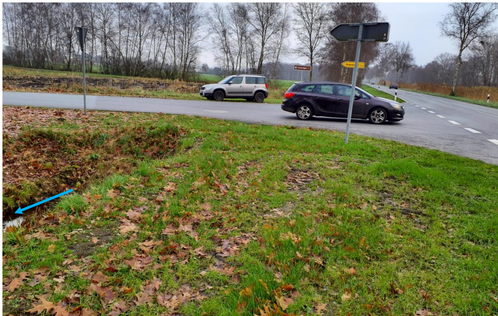
Abbildung 39: links im Bild Auslaufbereich Entwässerungsgraben parallel zur K19
