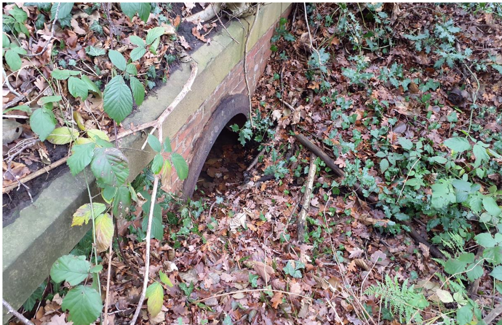
Abbildung 24: Auslauf südlich des Schachtes aus Abbildung 22
