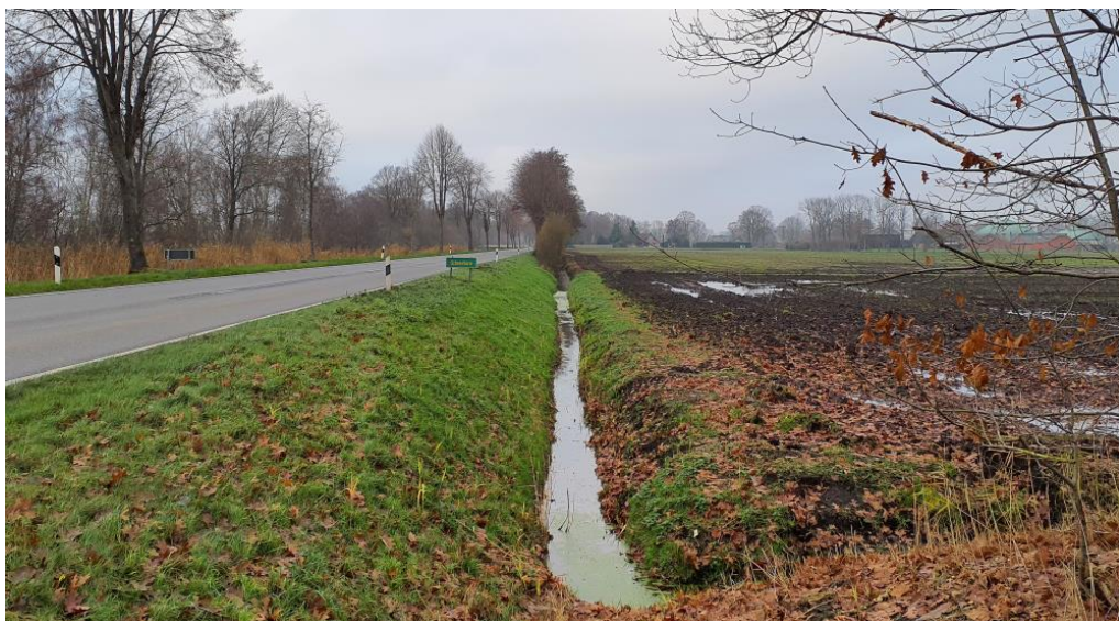
Abbildung 50: Entwässerungsgraben bei Achse 90
