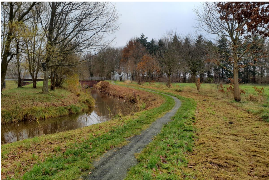
Abbildung 14: ehemaliger Schleusenkanal bei 43+600, Blickrichtung Osten
