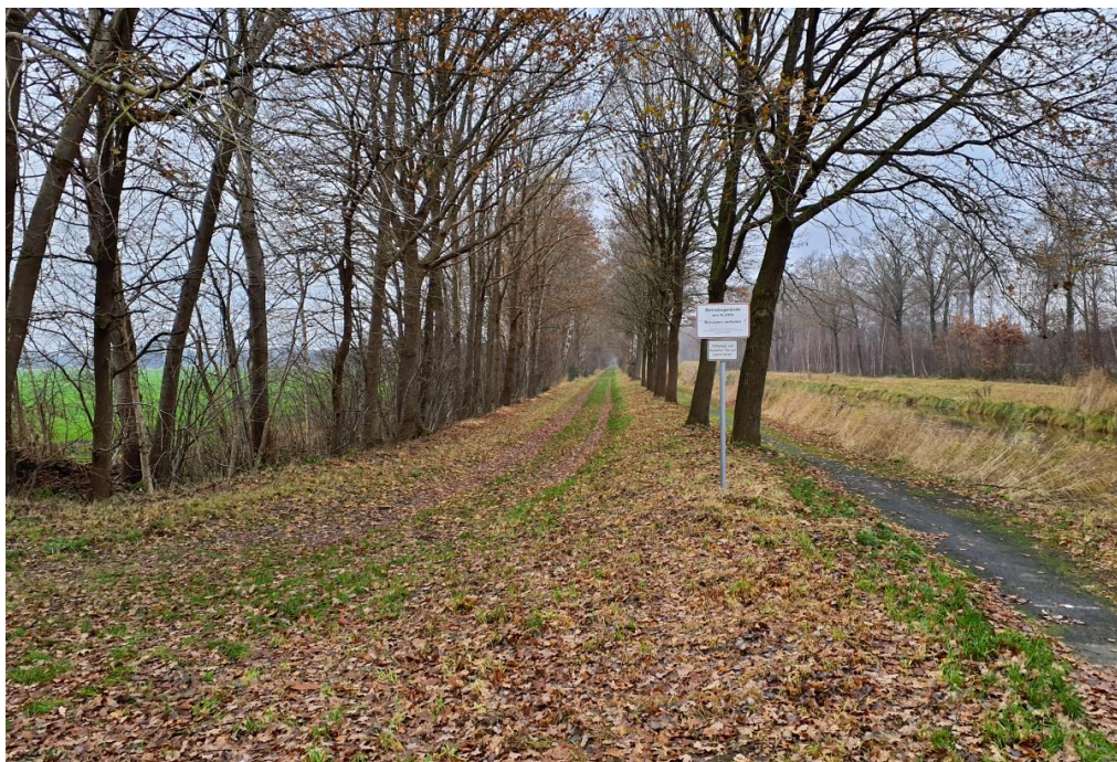
Abbildung 21: Auslauf Achse 3 mit Unterhaltungsweg (links) und Radweg (rechts) – Achse des geplanten Radweges verläuft hier auf der breiten Trasse des linken Unterhaltungsweges
