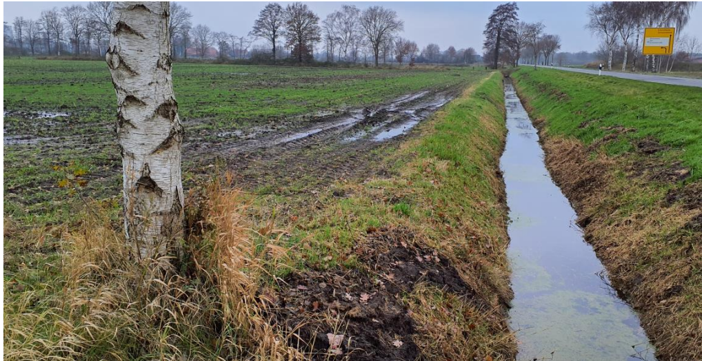
Abbildung 49: Entwässerungsgraben entlang Achse 82
