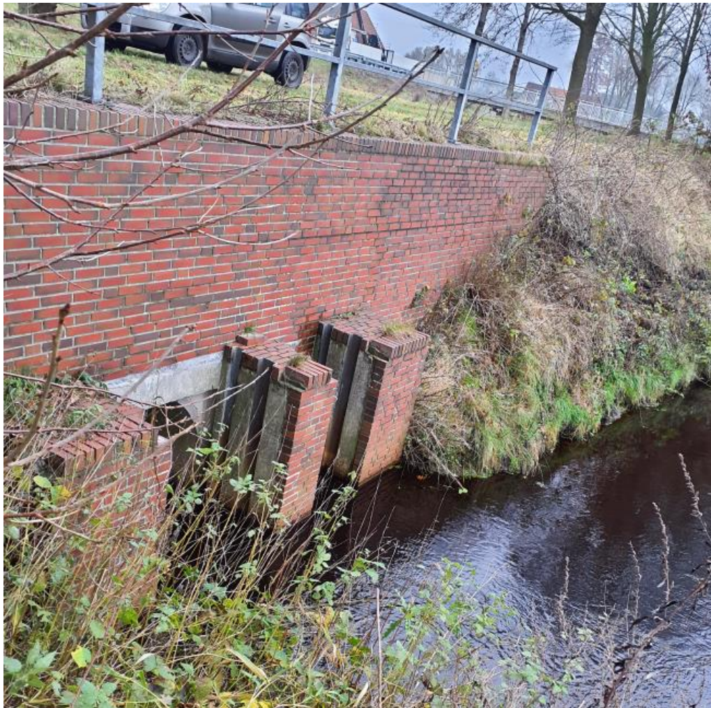
Abbildung 6: Auslauf Dükerbauwerk südlich PCK/Unterhaltungsweg bei 53+775
