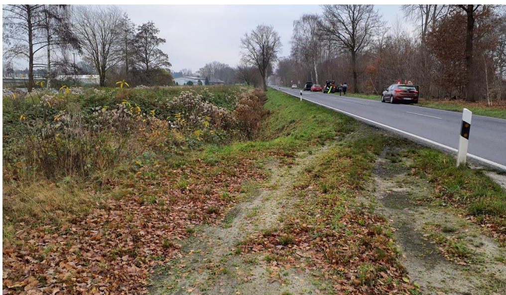
Abbildung 34: Entwässerungsgraben südöstlich der Industriestraße (Station 70+225)
