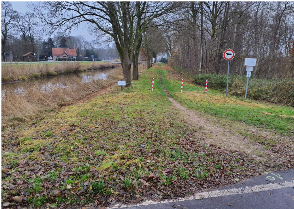
Abbildung 2: Beginn der Bearbeitungsstrecke südöstlich der Straße Kaveldiek in Osterwald mit Unterhaltungsweg und PCK (Blickrichtung Osten, Station 54+800)
