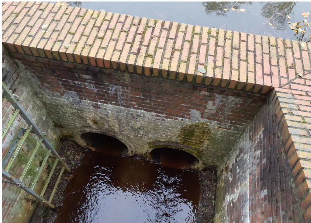
Abbildung 17: südlicher Auslauf Querungsbauwerk
