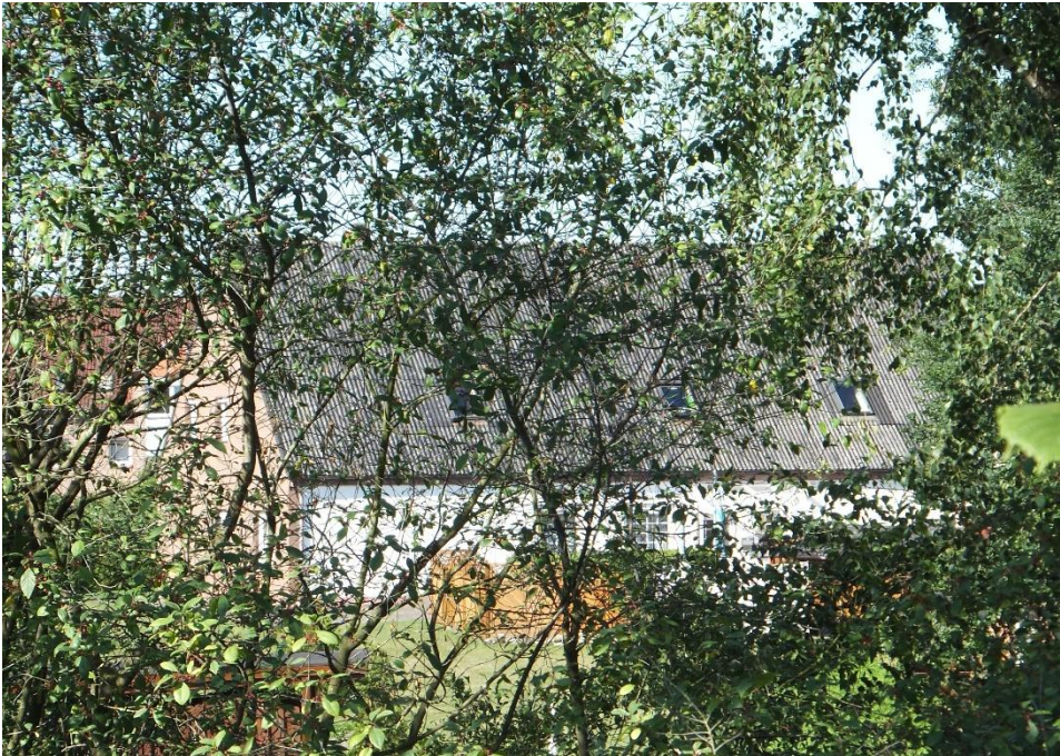
Abbildung 7: Wohngebäude Großen Straße 79 (377 m Abstand zur geplanten Trasse), Blick von der erhöht liegenden Hollenstraße aus
