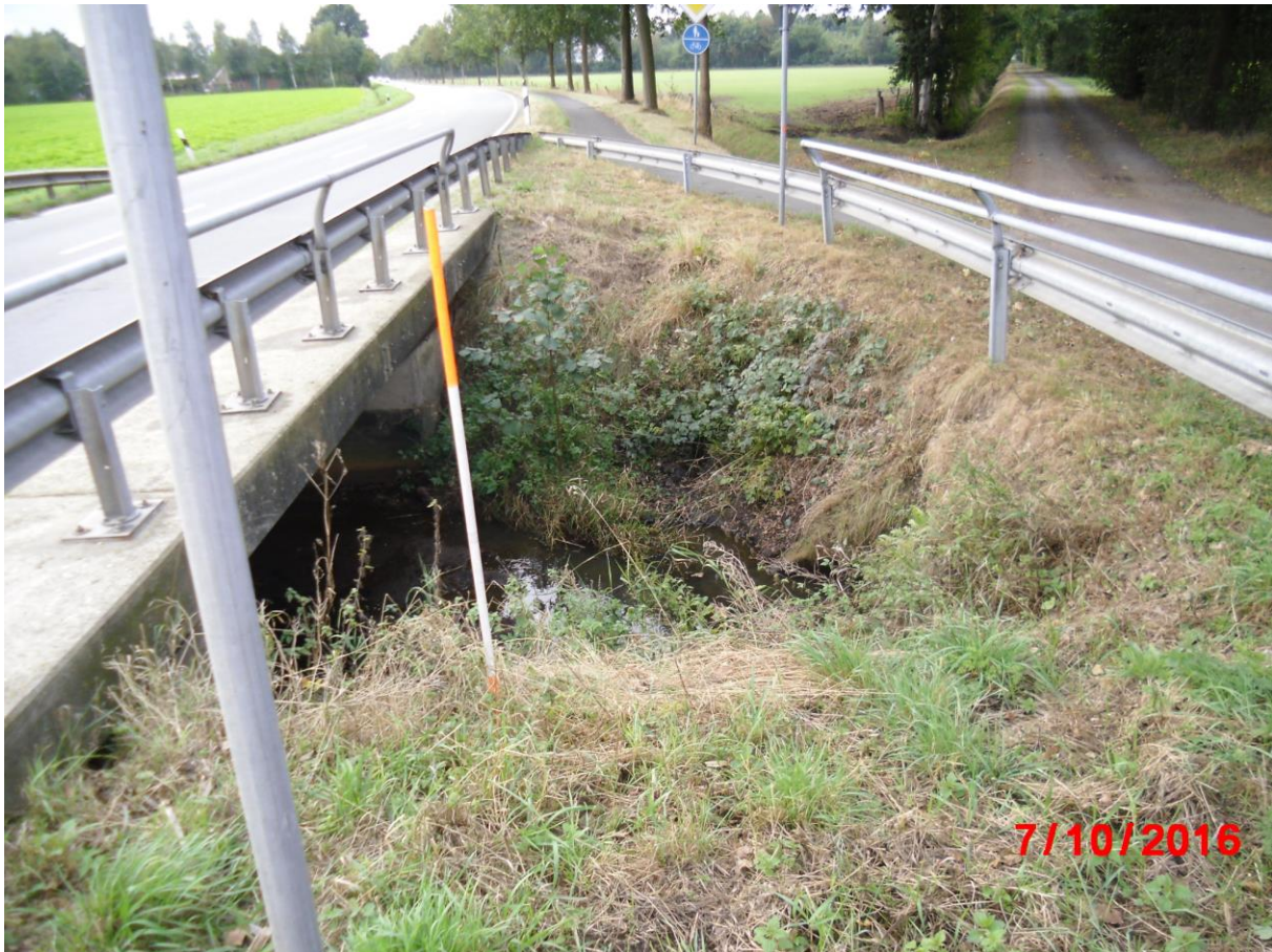
Abbildung 4-3: Vermessungsfoto der Brücke der L67 (links) und des Rad-/ Wirtschaftsweges (rechts) über den Klausheider Graben
