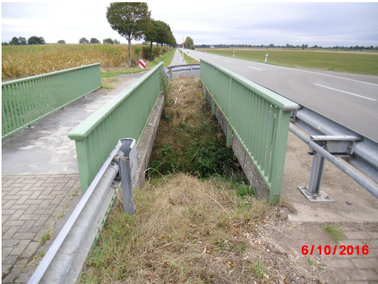
Abbildung 4-1: Vermessungsfoto der Brücke der L67 (rechts) und des Radweges (links) über die Lee
