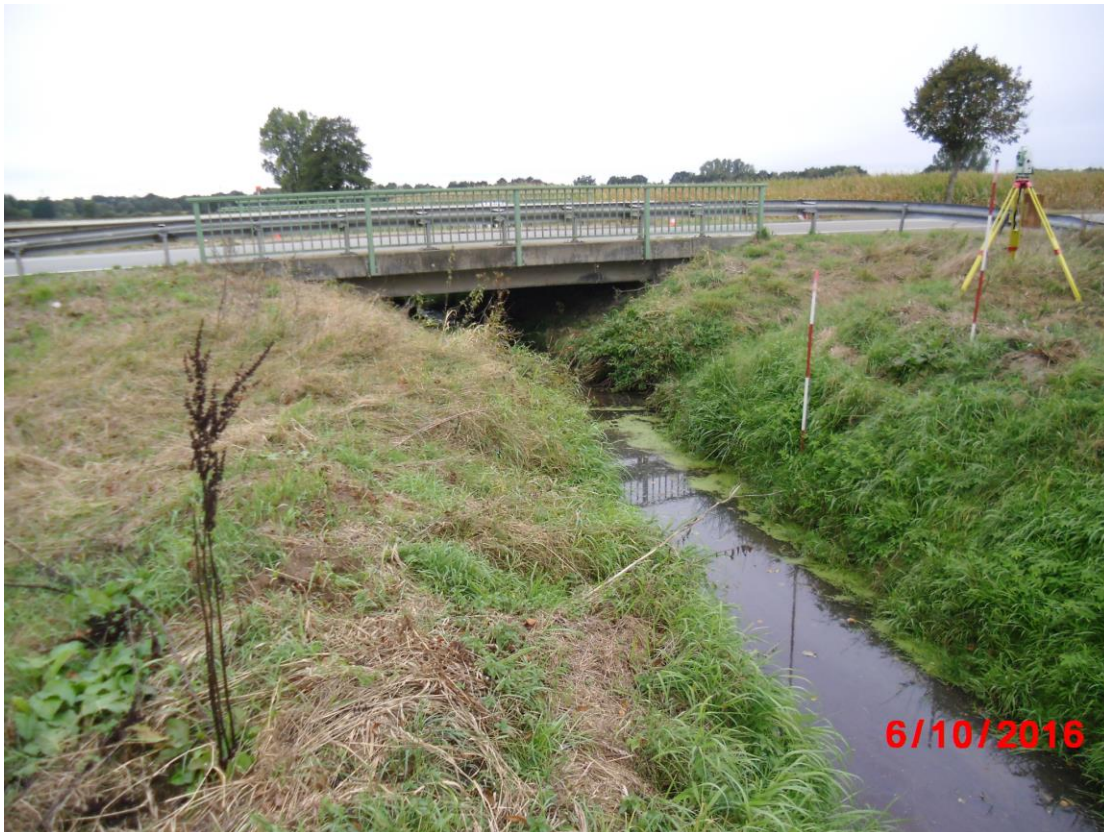
Abbildung 2-3: Vermessungsfoto der Brücke der L67 über die Lee
