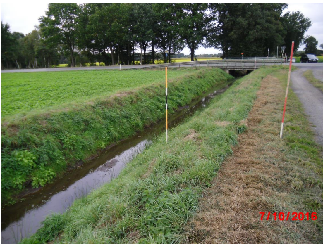
Abbildung 2-4: Vermessungsfoto der Brücke der L67 über den Klausheider Graben
