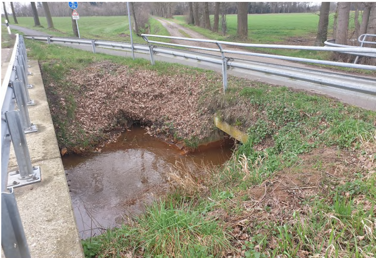
Abbildung 3: kurzer, offener Grabenabschnitt zwischen Bauwerk L 67 (links) und Durchlass i.Z.d. Alendieks (rechts)
