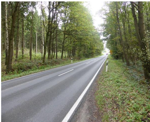
Abb. 4 Waldflächen im nördlichen Bereich des Bauabschnittes (Blickrichtung: Nordwest)
