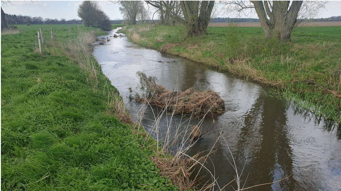
Abb. 5: Wietze oberhalb Planbereich: Totholzeinbau mit erkennbaren Gehölzansammlungen, Blick nach unterhalb (Foto: Ingenieurgesellschaft agwa, April 2023)
