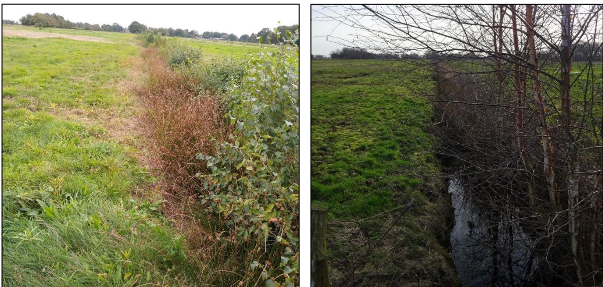
Abbildung 4: Graben bei Maßnahme Nummer 18. Links im Sommer, ausgetrocknet und mit terrestrischen bzw. Sumpfpflanzen überwachsen. Rechts: im Winter nach einer länger anhaltenden Regenperiode.
