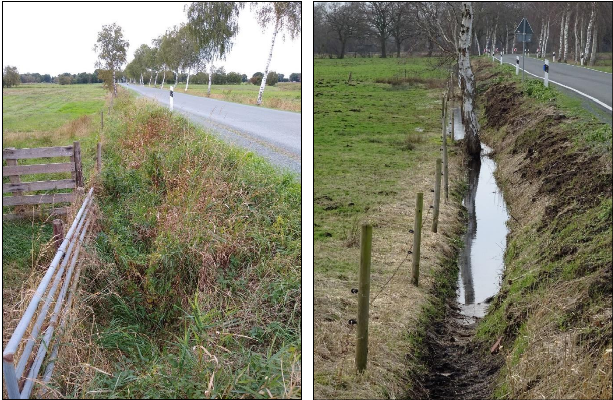
Abbildung 5: Graben bei Maßnahme Nummer 29b. Links im Sommer, ausgetrocknet und mit terrestrischen Pflanzen überwachsen. Rechts: im Winter nach einer länger anhaltenden Regenperiode stellenweise ohne Wasserführung.
