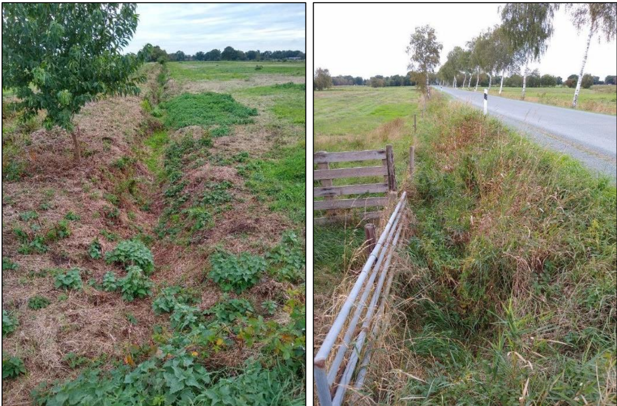
Abb. 1: (links) Trockengefallener und überwachsener Graben im nordwestlichen Bereich des Gebietes. (rechts) Straßengraben an der K 210, im Bereich des geplanten Versorgungswegs.
