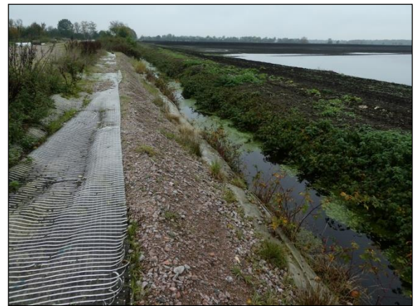
Abb. 20: Grabenabschnitt 11, ein Teil der südlichen Böschung ist bereits mit Schotter angeschüttet.
