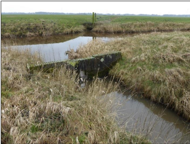
Abb. 53: Graben (FGR) am süd-westlichen Rand von Flurstück 20/1 mit Staumauer
