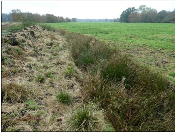
Abb. 18: Umleitung von Grabenabschnitt 10 um den Kranstellplatz herum.
