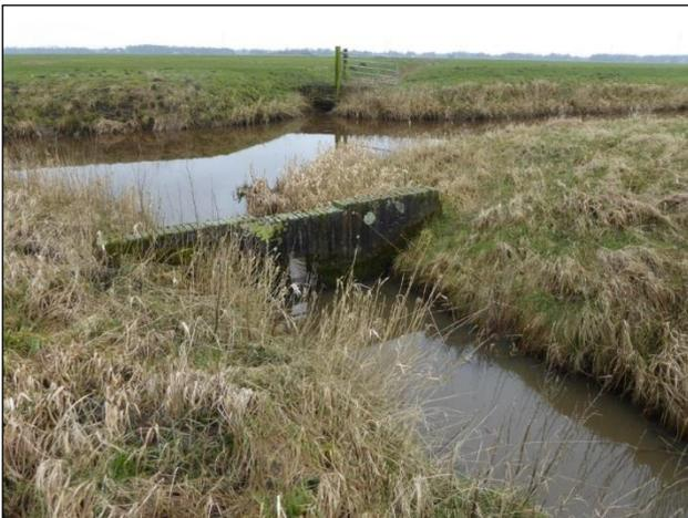
**Abb. 5: Graben (FGR) am süd-westlichen Rand von Flurstück 20/1 mit Staumauer**
