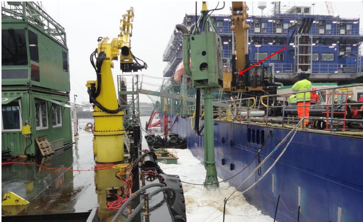
Abbildung 30: Beispiel einer Dredge Operating Pump (DOP) in Testbetrieb
