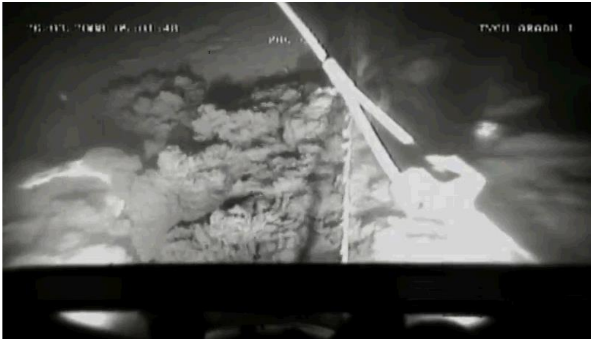
Abbildung 16: Sedimentschleppen und Trübungswolken hinter dem Spülschlitten
