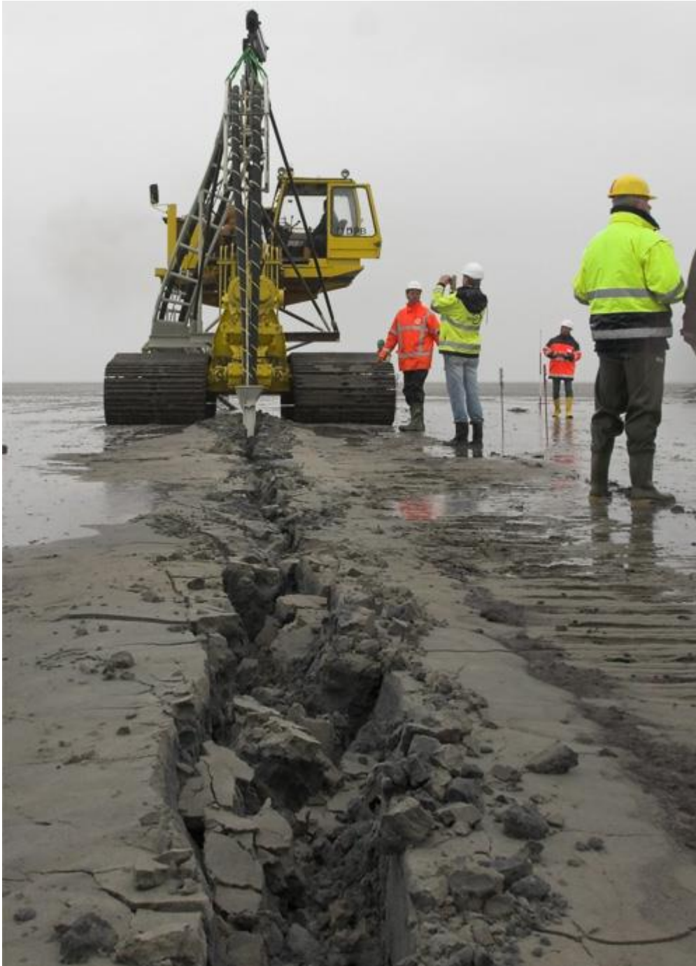
Abbildung 5: Kabellegung im Wattenmeer (Sandwatt) mit Vibrationskabelpflug
