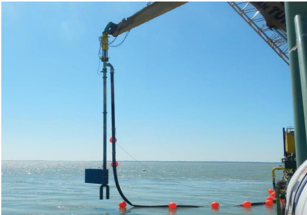
Abbildung 28: Hydraulikbagger mit Spüllanze
