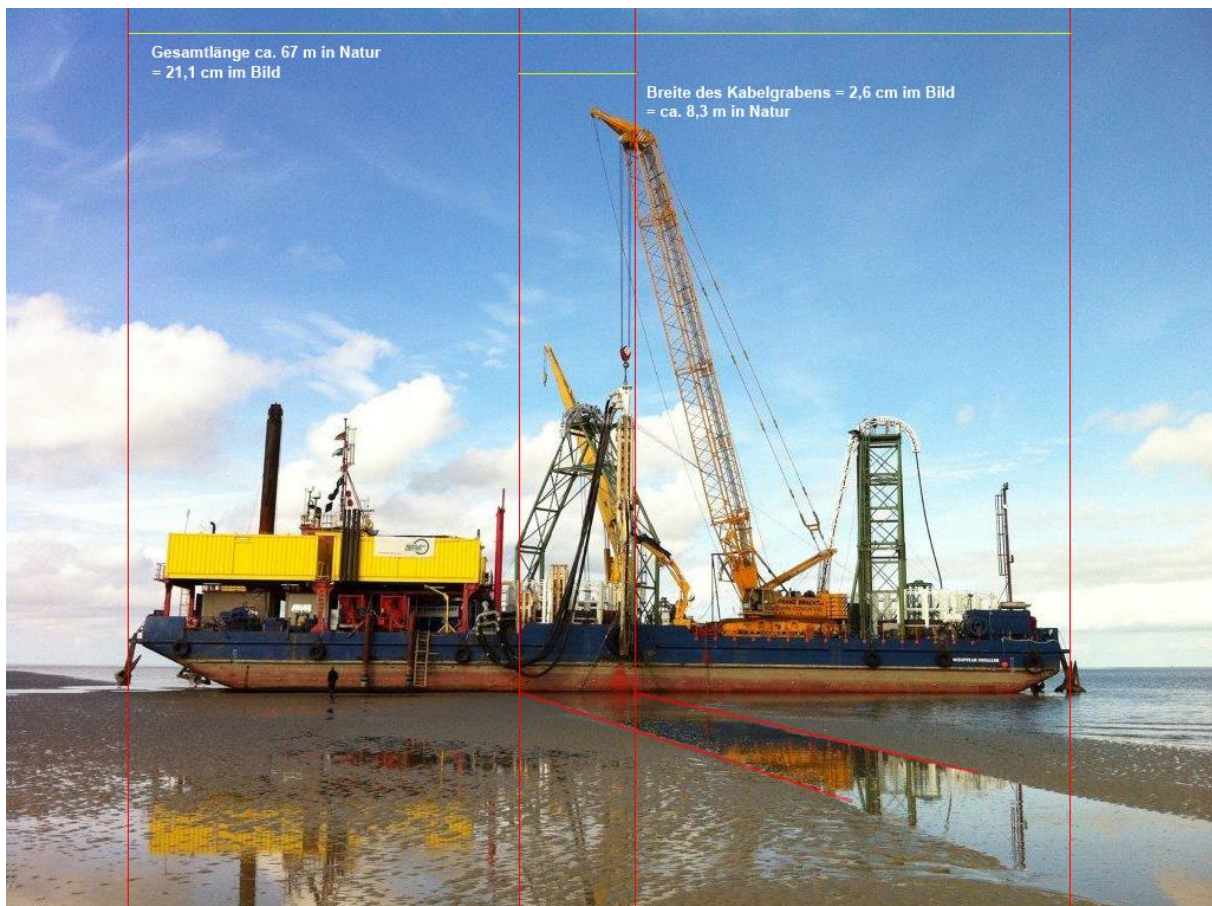
Abbildung 24: Nach Kabeleinspülung mit dem Vertical Injector im Tertiussand entstandene Grabenmulde im Watt inkl. Abschätzung der Breite (Bild 19)
