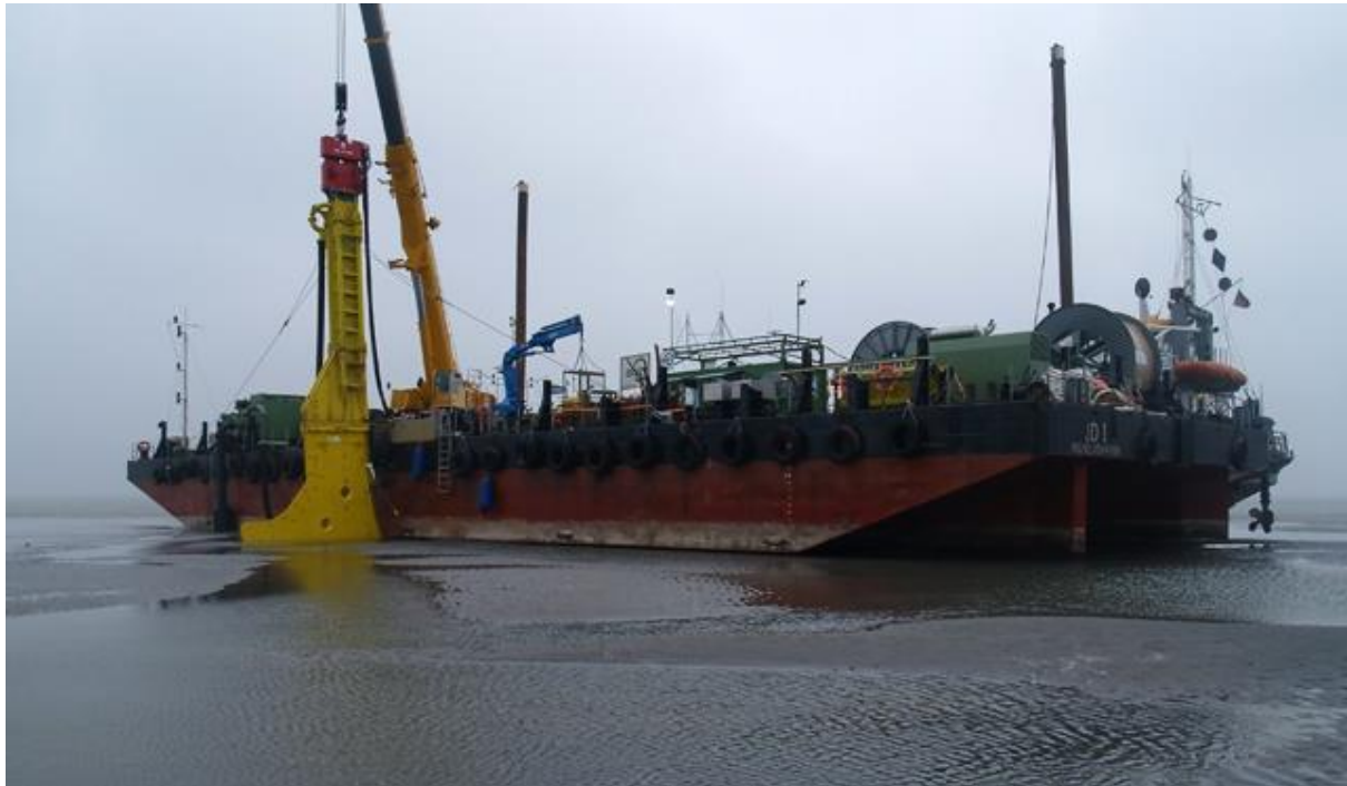
Abbildung 8: Kabellegung im Wattenmeer mit Vibrationsschwert an Barge
