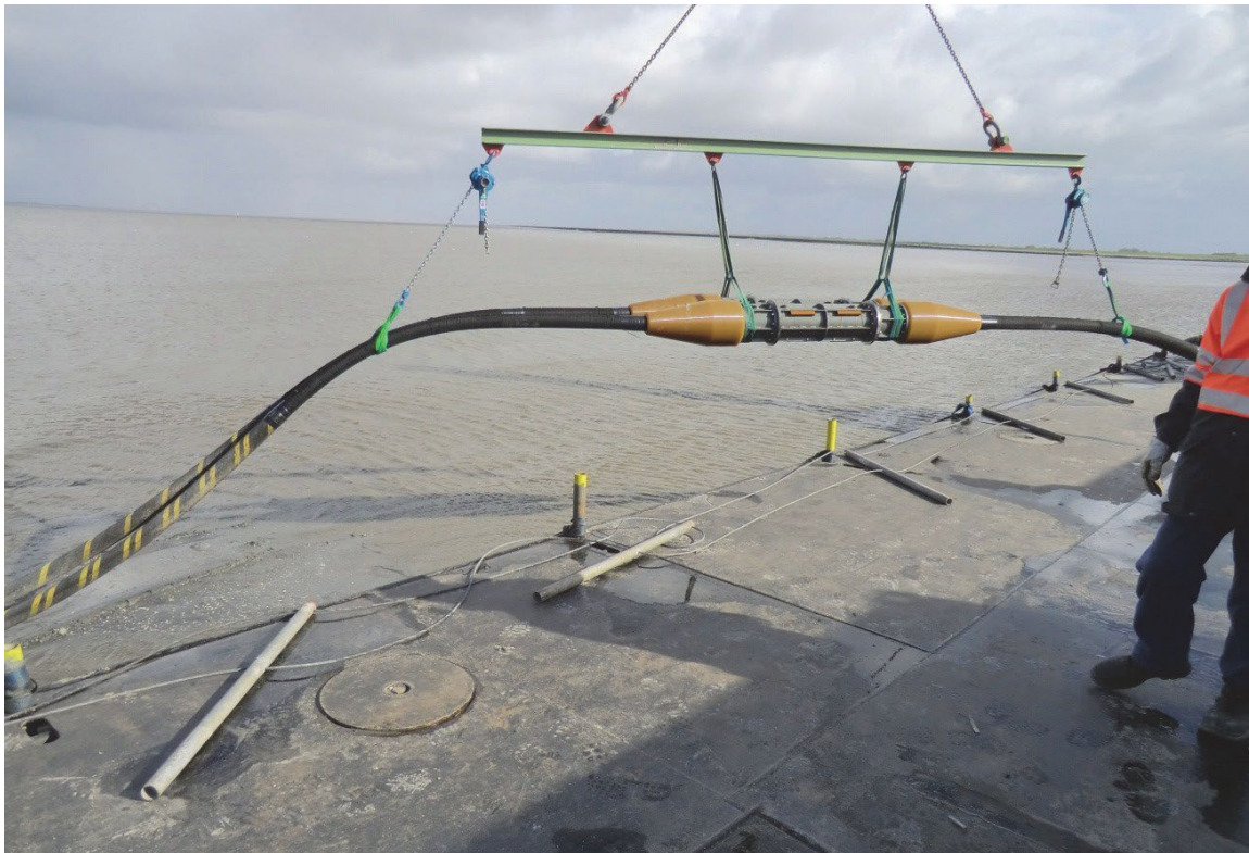
Abbildung 33: Ablegen einer Seekabelmuffe (Quelle: eos projekt).
