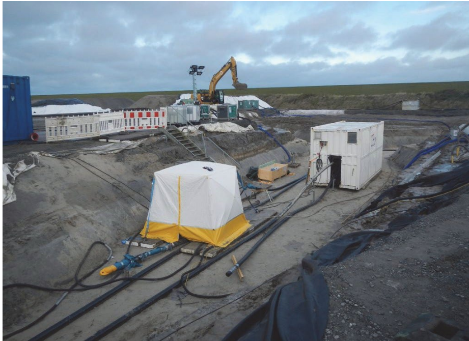
Abbildung 22: Muffengrube Hilgenriedersiel (Quelle: eos projekt).
