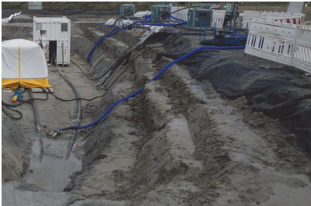
Abbildung 23: Drainage Muffengrube (Quelle: eos projekt).
