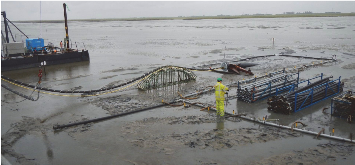
Abbildung 15: Wasserhaltung Watt (Quelle: eos projekt).
