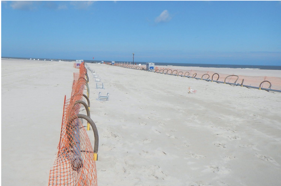
Abbildung 25: mögliche Wasserhaltung im Strandbereich (Quelle: eos projekt).
