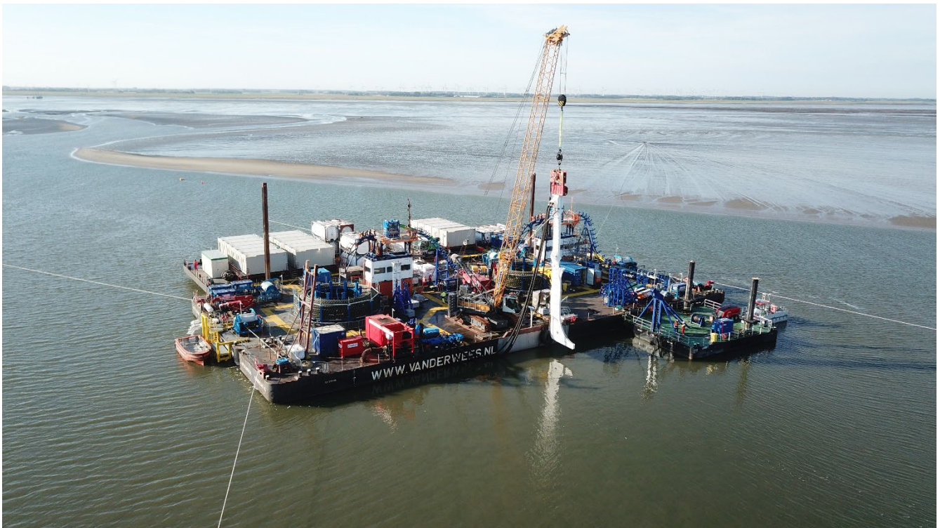
Abbildung 14: Kabelverlegebarge bei Hochwasser mit Vibrationsschwert (Quelle: TenneT).
