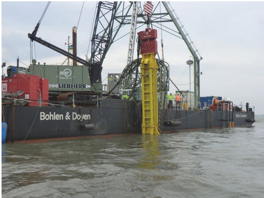
Abbildung 18: Vibrationsschwert im Einsatz (Quelle: eos projekt).
