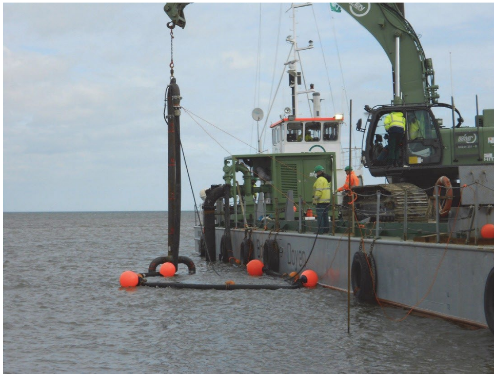
Abbildung 34: Einspülen des Kabels mit einer Doppelspüllanze (Quelle: eos projekt).
