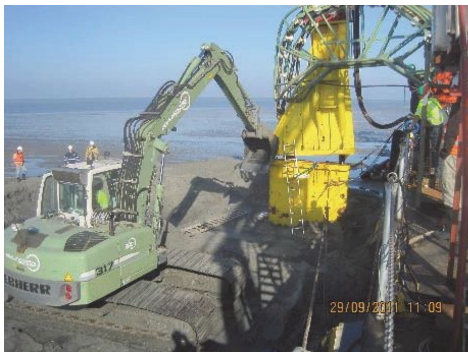
Abbildung 17: Vibrationsschwert in Startgrube (Quelle: eos projekt).
