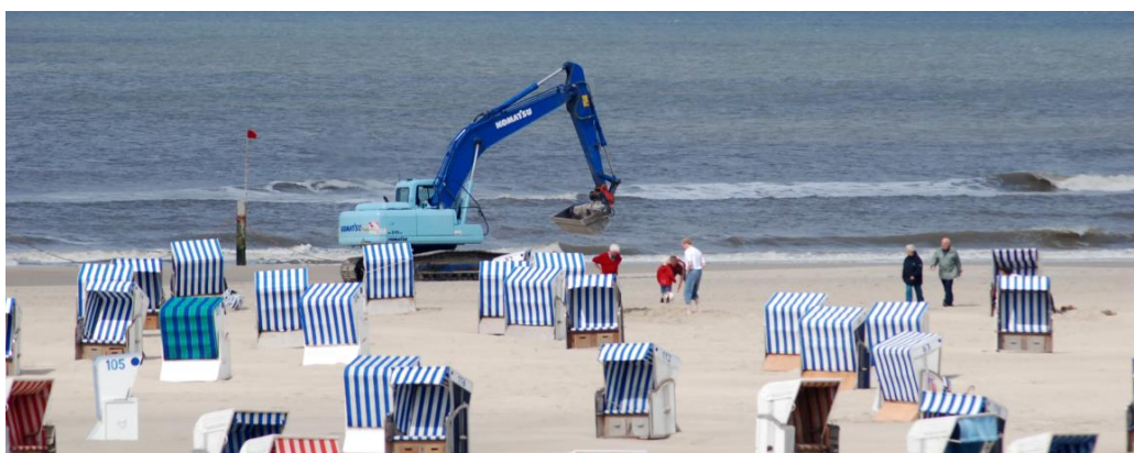
Abbildung 14: Baustellenverkehr am Badestrand bei Hochwasser
