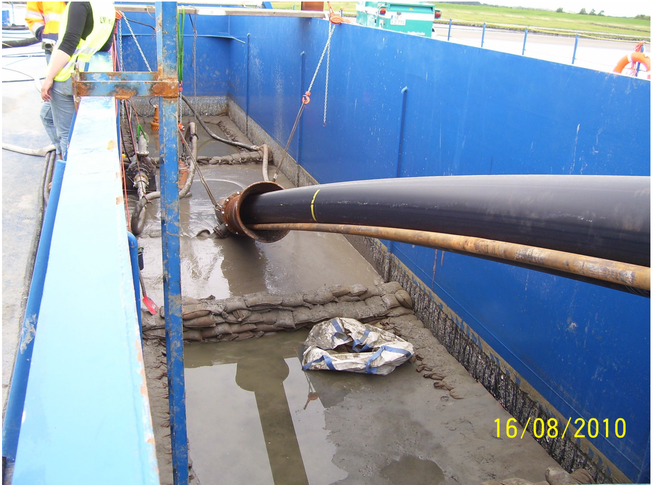
Abbildung 10: Beispiel (DoWin1) Einzug des Bohrgestänge mit dem Produktrohr (Pipe-Site)
