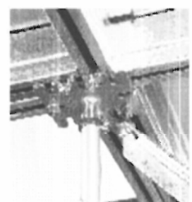
Rahmen aus C-Profilen mit Diagonalverspannungen für Schaltschränke
